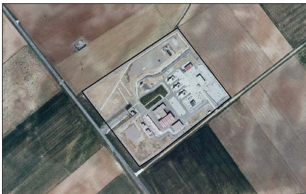
Figura 4: Estación de Compresión de Coreses (Zamora)
