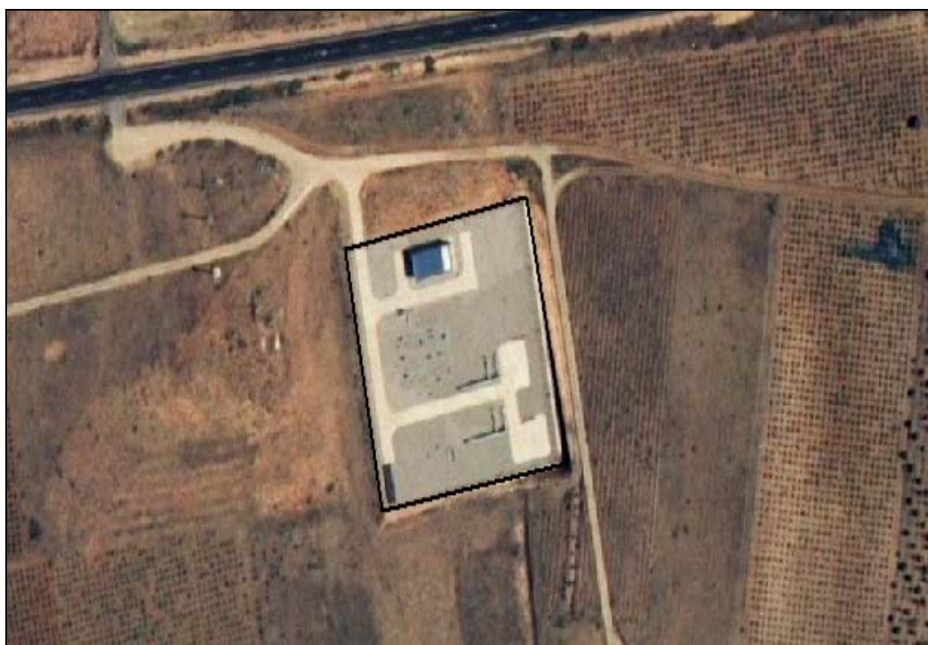
Figura 1: Estación de Regulación y Medida
