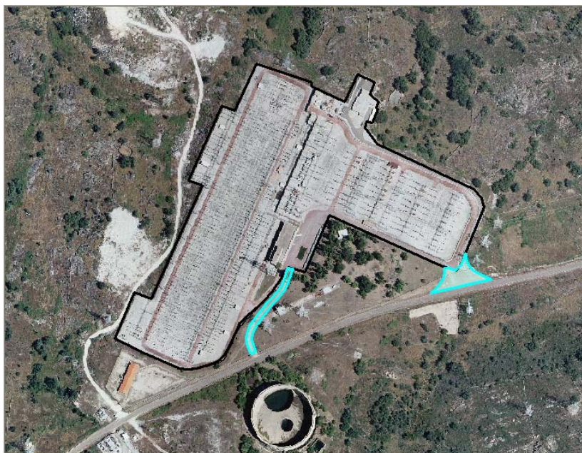
Figura 11: Ejemplo de acceso a una subestación
