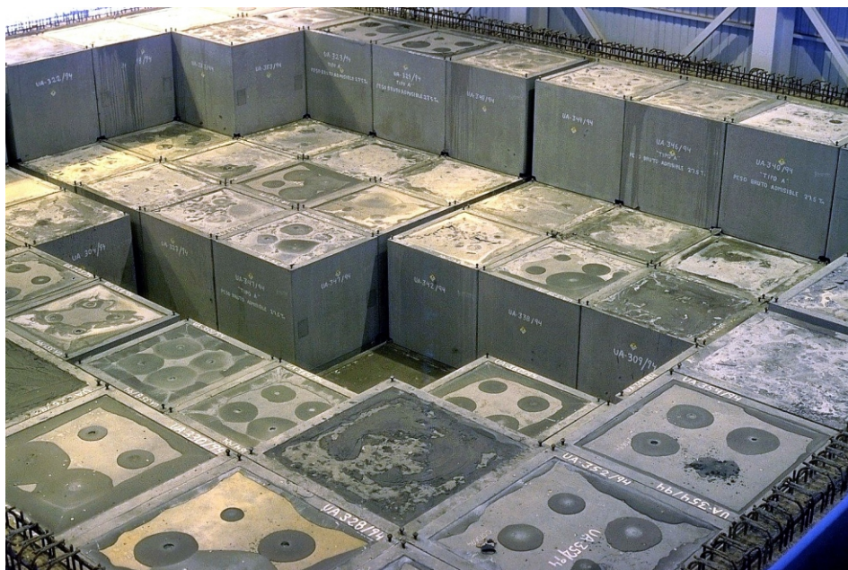
Detalle de contenedores para el almacenamiento de RMBA en la celda de almacenamiento de El Cabril.
