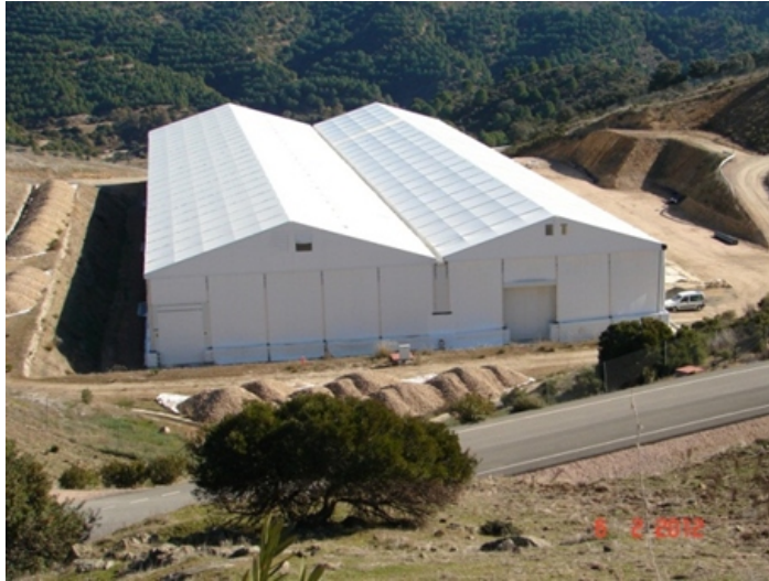
VLLW disposal cell at El Cabril (cell 29).
