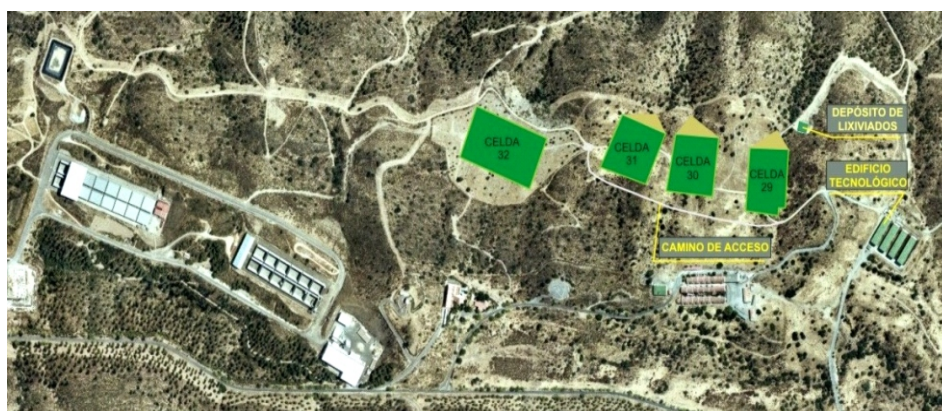
Figura 6. Vista aérea. Instalación de residuos de muy baja actividad.
