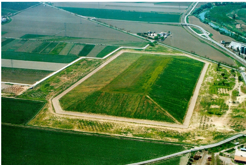
Imagen del emplazamiento restaurado de la antigua Fábrica de Uranio de Andújar.
