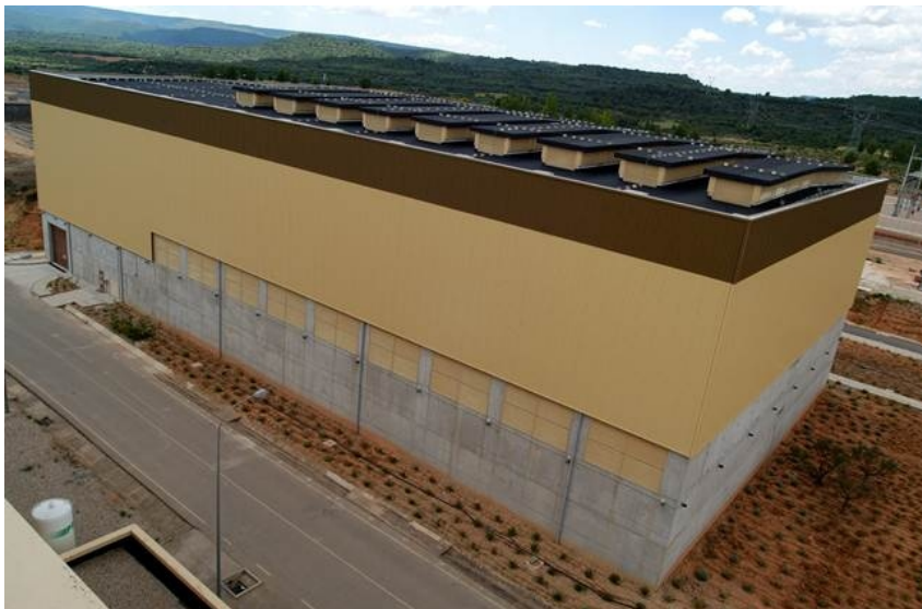
Imagen del Almacén Temporal Individualizado de la central nuclear de Trillo.
