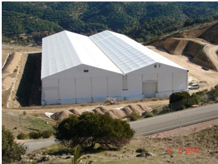
Imagen de la celda de almacenamiento de RBBA en El Cbril (celda 29).
