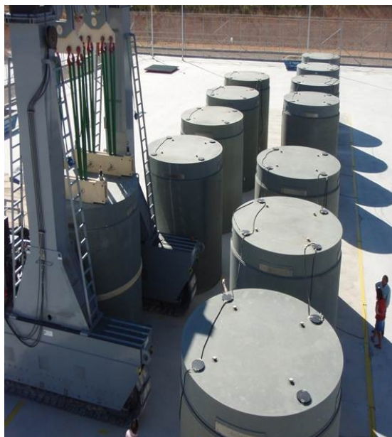
Imagen del ATI de la central nuclear de José Cabrera.
