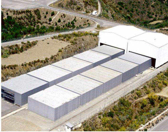
Imagen de celdas de RBMA del Centro de almacenamiento de ENRESA en El Cabril.
