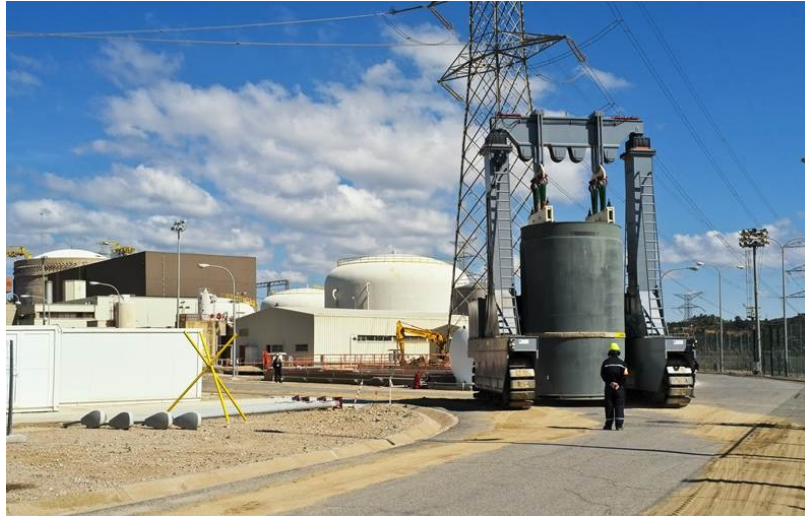
Transporte de contenedor de combustible gastado hasta el ATI, central nuclear de Ascó.
