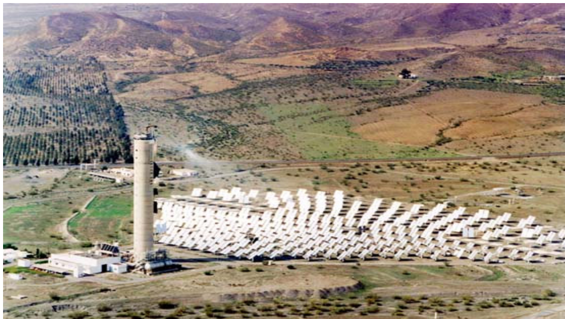
Figura 2. Plataforma Solar Almería CESA-1
