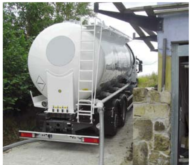
Figura 12: Recarga de silo mediante camión cisterna neumático
