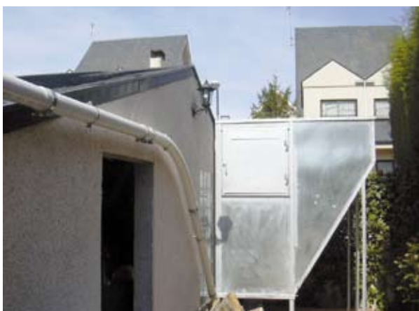
Figura 15: Tolva exterior con alimentación mediante tornillo sinfín
