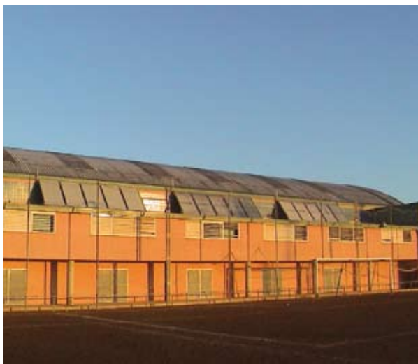
Figura 52: Instalación mixta de biomasa y solar térmica en pabellón de deportes
