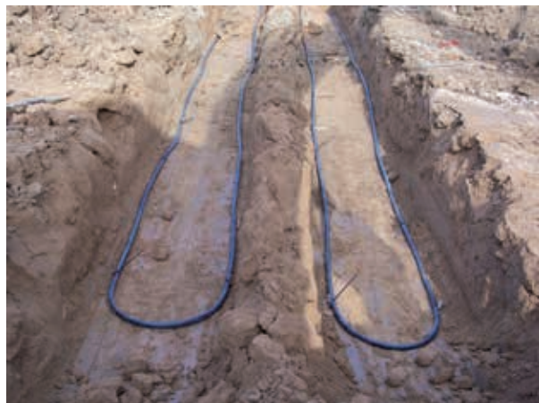
Figura 6.3: Detalle del intercambiador horizontal de lazo simple
