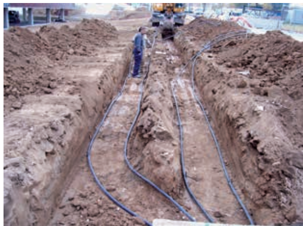
Figura 6.2: Intercambiador horizontal de lazo simple
