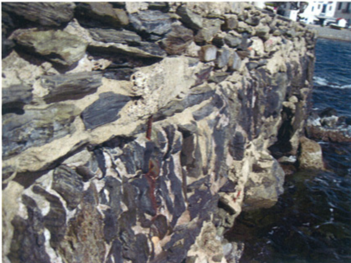
F1- Zona del Ayuntamiento Muelle del Castell
