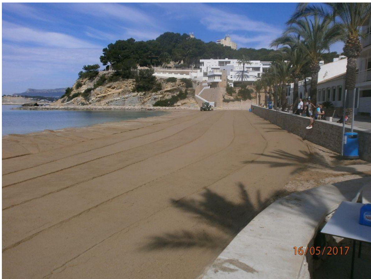
Después de las obras (El Portet)
