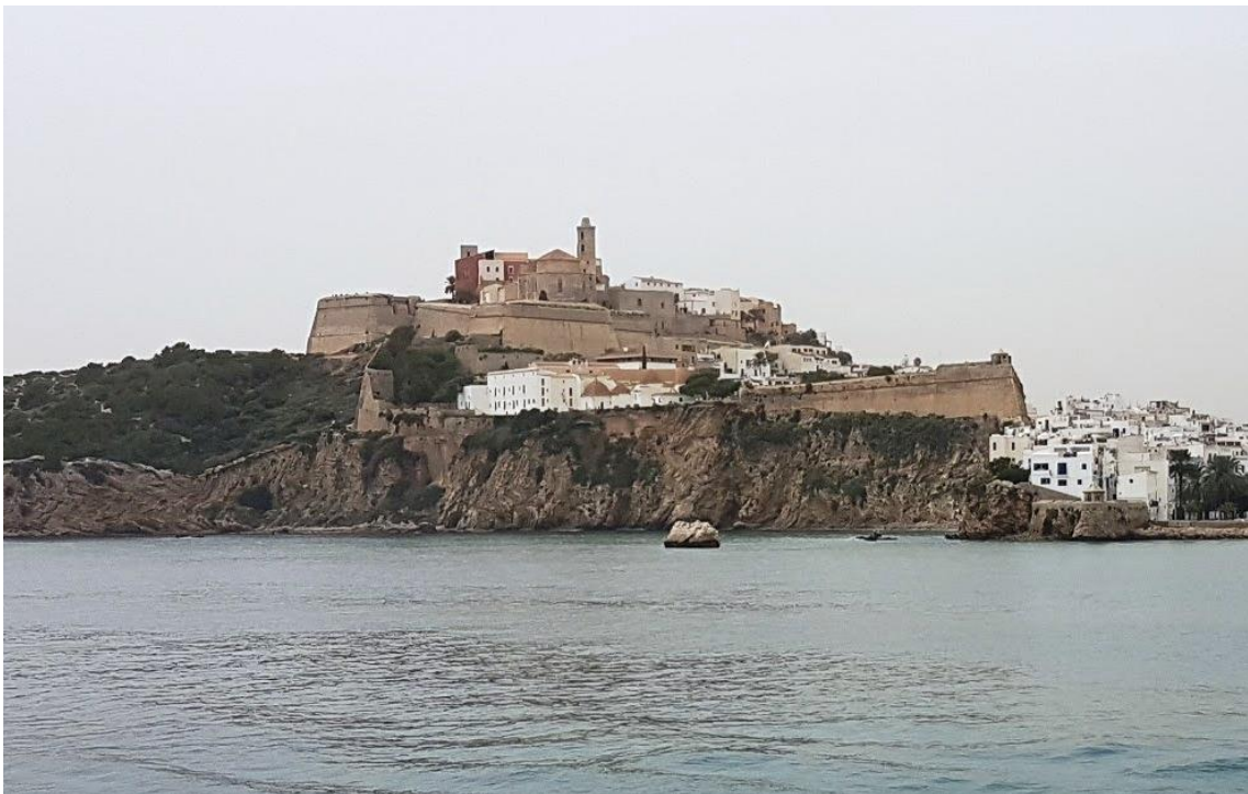
Vista frontal de la zona afectada.
