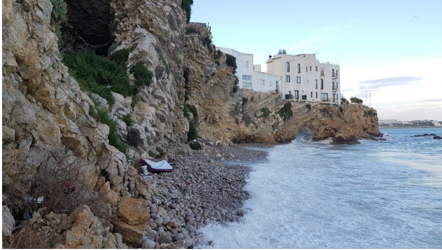
Viviendas en zona Noreste descalzadas.
