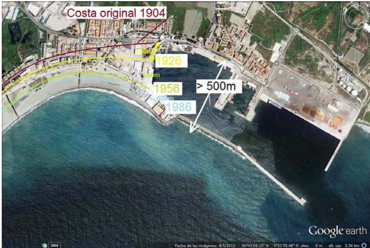
Figura 6.14: Situación aproximada de las diversas líneas de costa de la playa del Pelaillo apoyada en el dique del puerto de Motril (Foto: Google Earth)
