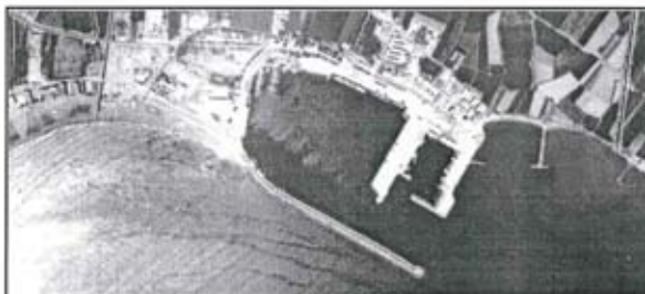
Figura 3.2: Puerto de Motril 1986
