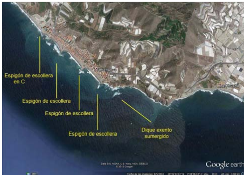
Figura 2.7: Obras costeras en el término municipal de Motril (Foto: Terra Metrics-Google Earth)
