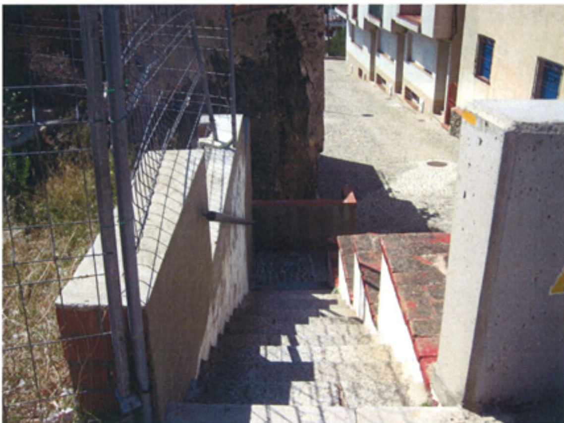
F3 Escalera acceso al al Playa de Port Bou
