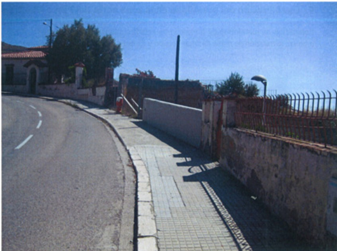
F2 Estado actual de la acera
