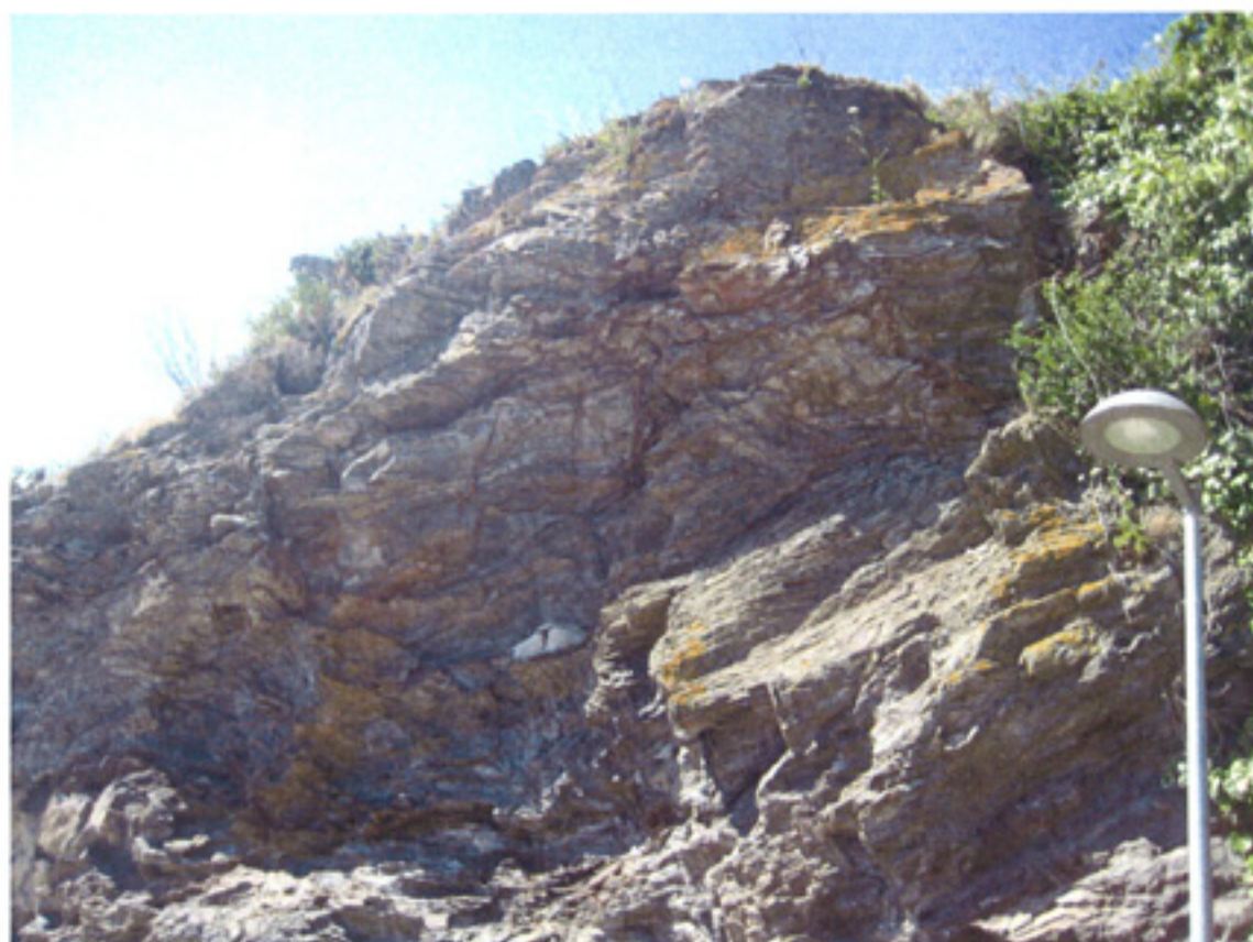
F9 Zonas a sanear y habilitar median malla metálica.
