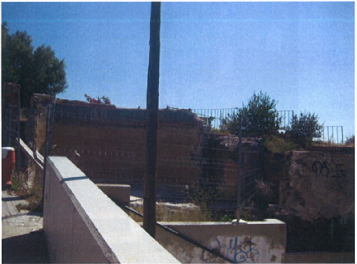
F4 Demolición del depósito
