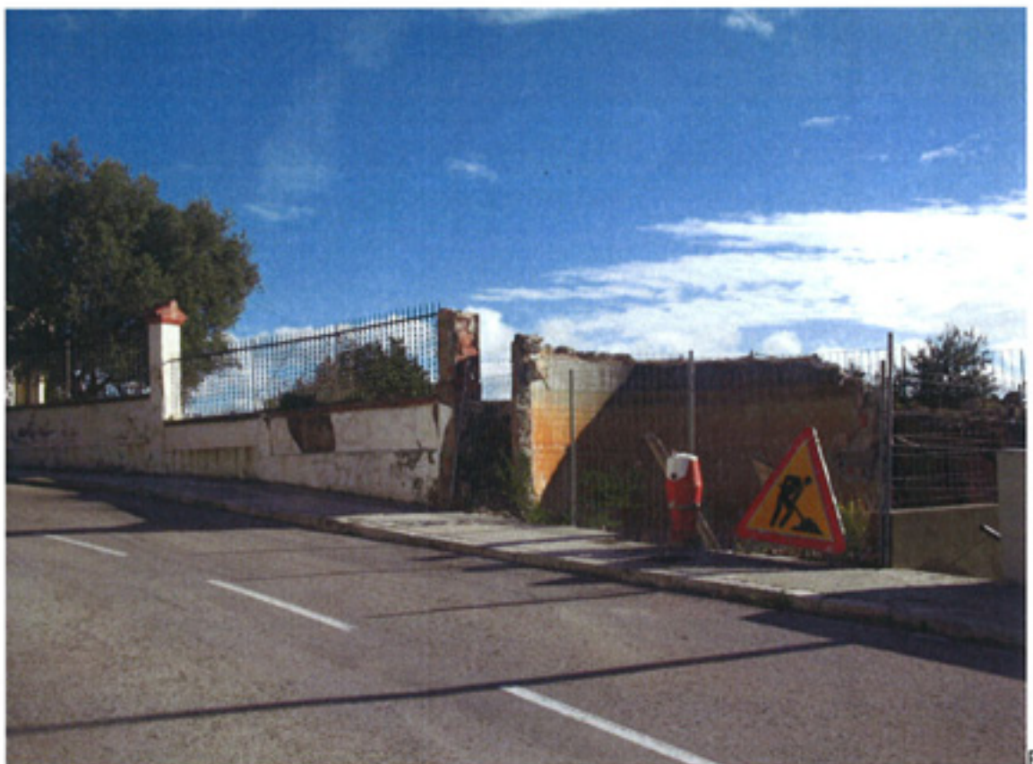
F5 Zona a pavimentar y recuperar.
