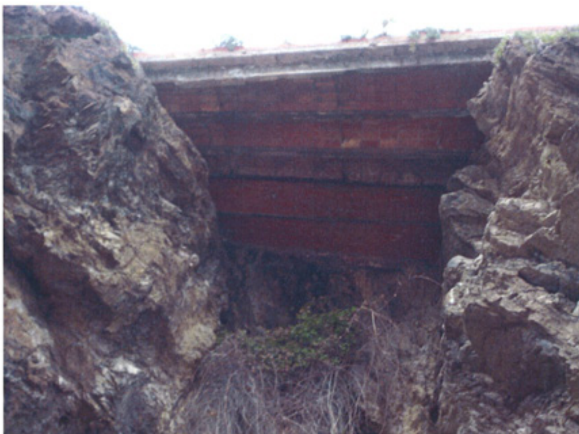
F10 Estado actual de la terraza.
