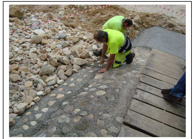
Trabajos de ampliación de rampa de acceso
