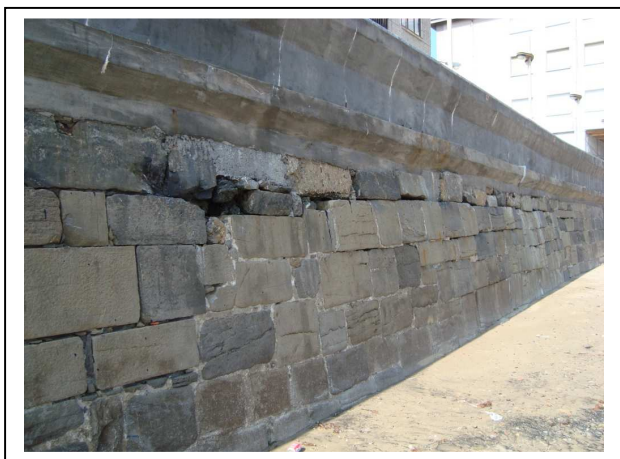
Antes de la actuación
