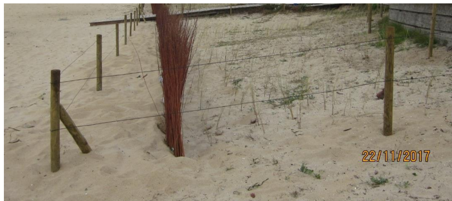
Después de la obra
