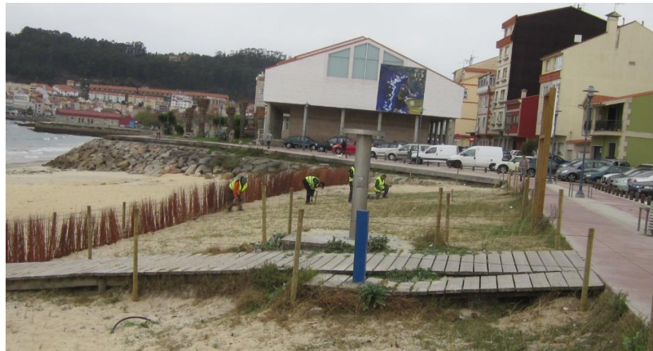
Durante la obra
