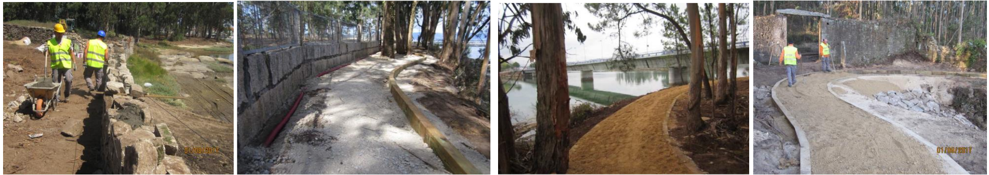
Durante la obra
