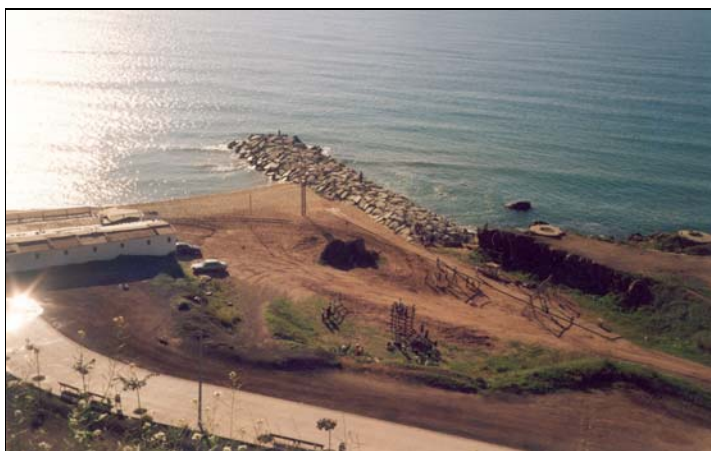
Barreras al paso de sedimentos
