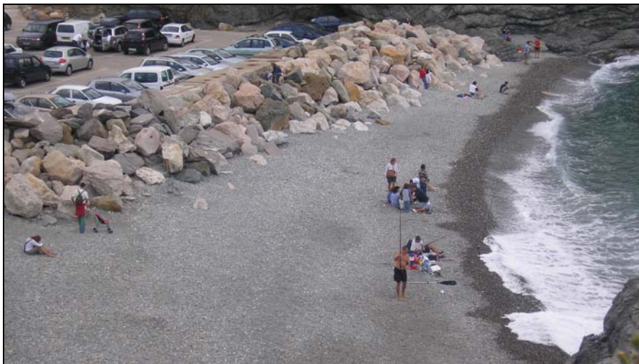
Dique longitudinal en una playa
