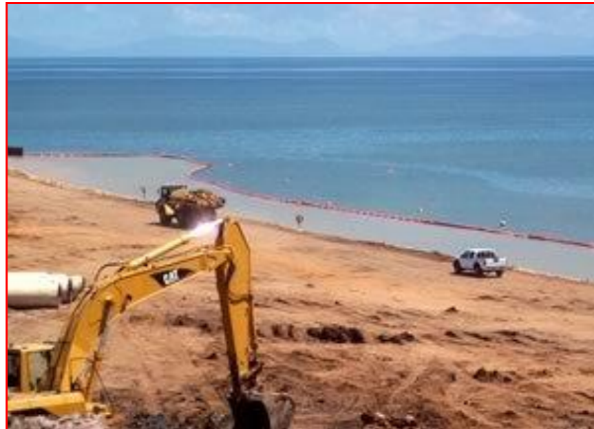
Ejemplo de uso de barreras antiturbidez en obras de regeneración de playas.
