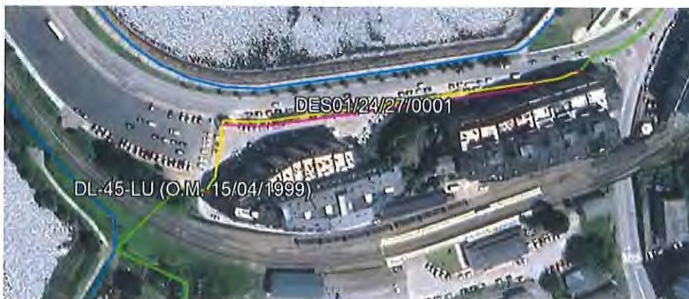
Imagen parcial de tramo rectificado
