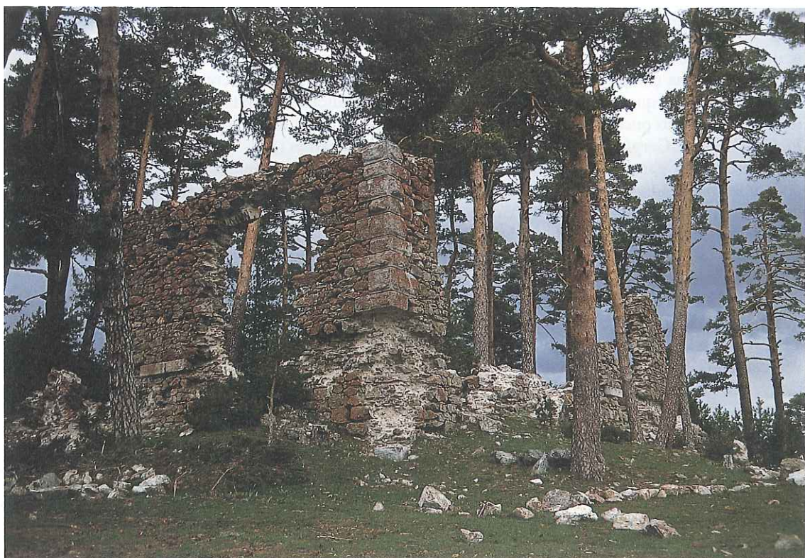
Ruinas de la Casa de la Nieve, en las inmediaciones del Puerto de Fuenfría. Aunque popularmente se consideran estos restos como pertenecientes a un denominado Convento de Casarás, en el Monasterio de El Escorial existe un cuadro anónimo que reproduce la Casa de la Nieve en su estado original. Este edificio, construido en el siglo XVI servía como lugar de descanso de los reyes y para almacenamiento y conservación de nieve para el gasto del Palacio de Valsáin
