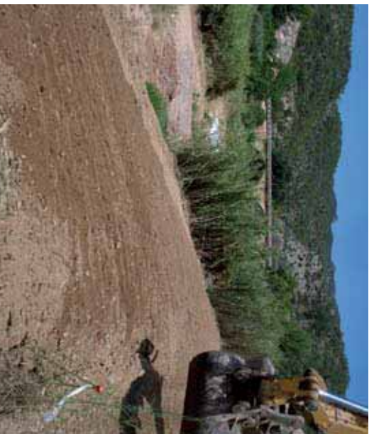
Figura 41. La longevidad de las coberturas, como estos geotextiles no tejidos, puede prolongarse cubriéndolas con el sustrato que se obtenga en el mismo lugar de la actuación. Imágenes: DGA (MAGRAMA) – TRAGSA.
