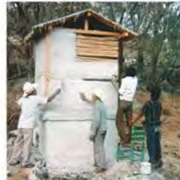
Construcción de un sanitario
