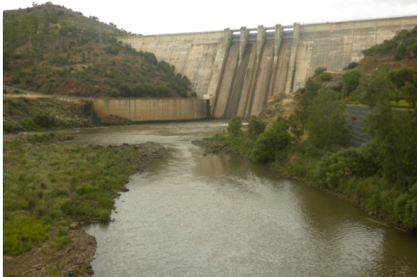
Presa en el río Chanza, Huelva, España (Foto propia)
