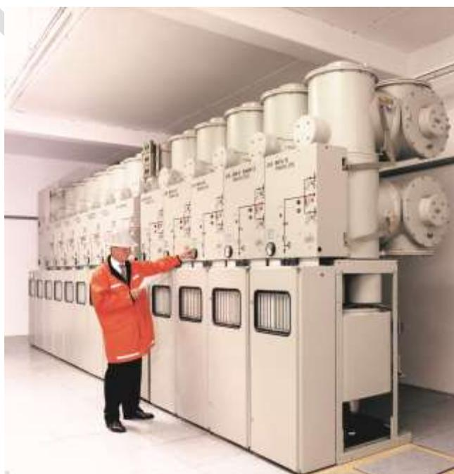
Figura 1. Celda sellada Media Tensión (izda). Celda cerrada Alta Tensión (dcha.) (Fuente: AFBEL)
