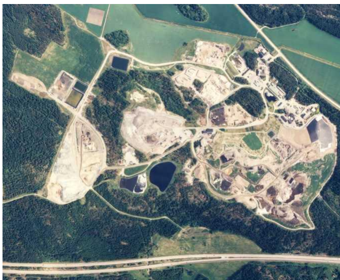
Figure 1.14-1: Overview of the landfill Högbytorp (Sweden)
