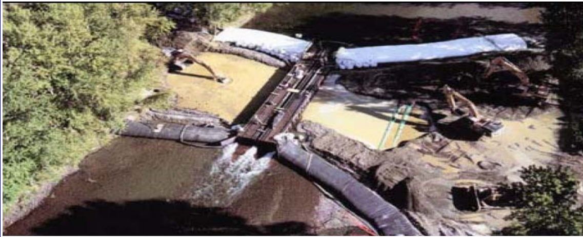
Figura 6. Presas formadas con conductos plásticos rellenos de agua en cruce de cauces por desvío de caudal mediante presas y obras de drenaje
