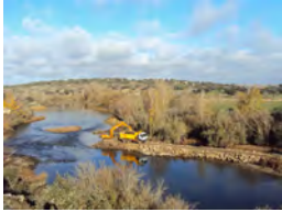
Obra de mejora longitudinal en sistema fluvial. Fotografía perteneciente al banco de imágenes del Grupo Tragsa
