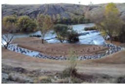
Obra de mejora longitudinal en sistema fluvial. Fotografía perteneciente al banco de imágenes del Grupo Tragsa
