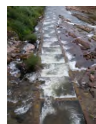
Escala de peces en el Parque Fluvial de los ríos Híjar y Ebro. Fotografía perteneciente al banco de imágenes del Grupo Tragsa
