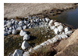
Ejemplo de mejora de la morfología del cauce. Trampa de sedimentos
