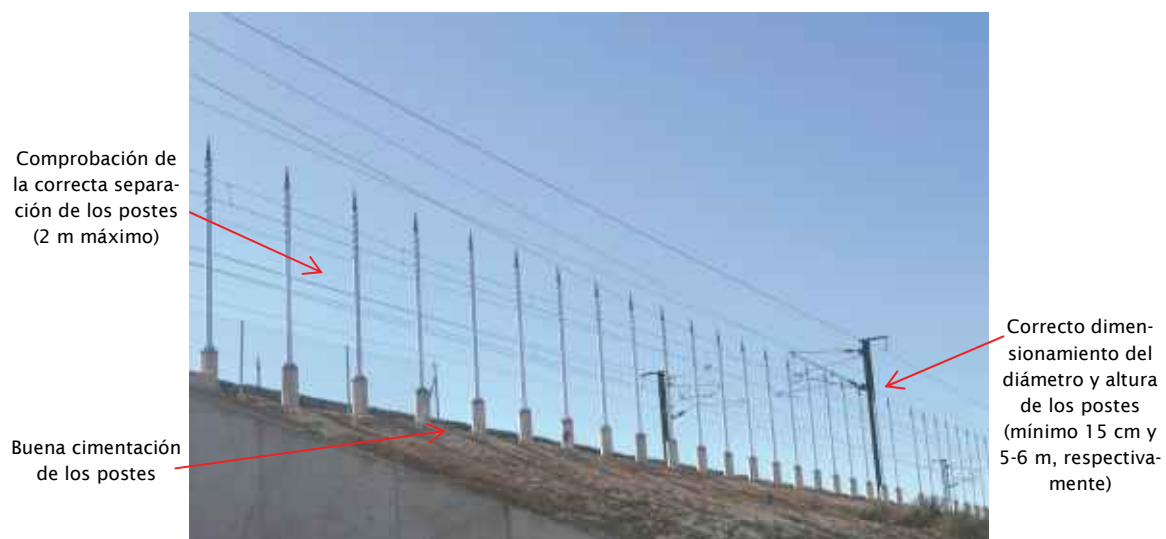
Figura 7.2. Dispositivo anticolidión junto a vía férrea formado por postes exentos que impiden que las aves en vuelo entren en área de colisión con los vehículos circulantes o los elementos de la vía. Foto: Life Impacto cero (Life12 BIO/ES/0000660).
