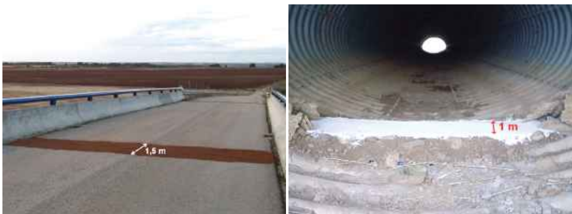
Figura 9.2. Disposición de bandas de control de huellas. En la imagen de la izquierda se usa arena de grano fino en paso superior multifuncional. En la de la derecha se usa marmolina en drenaje de chapa corrugada. Fotos: TEG-UAM.
