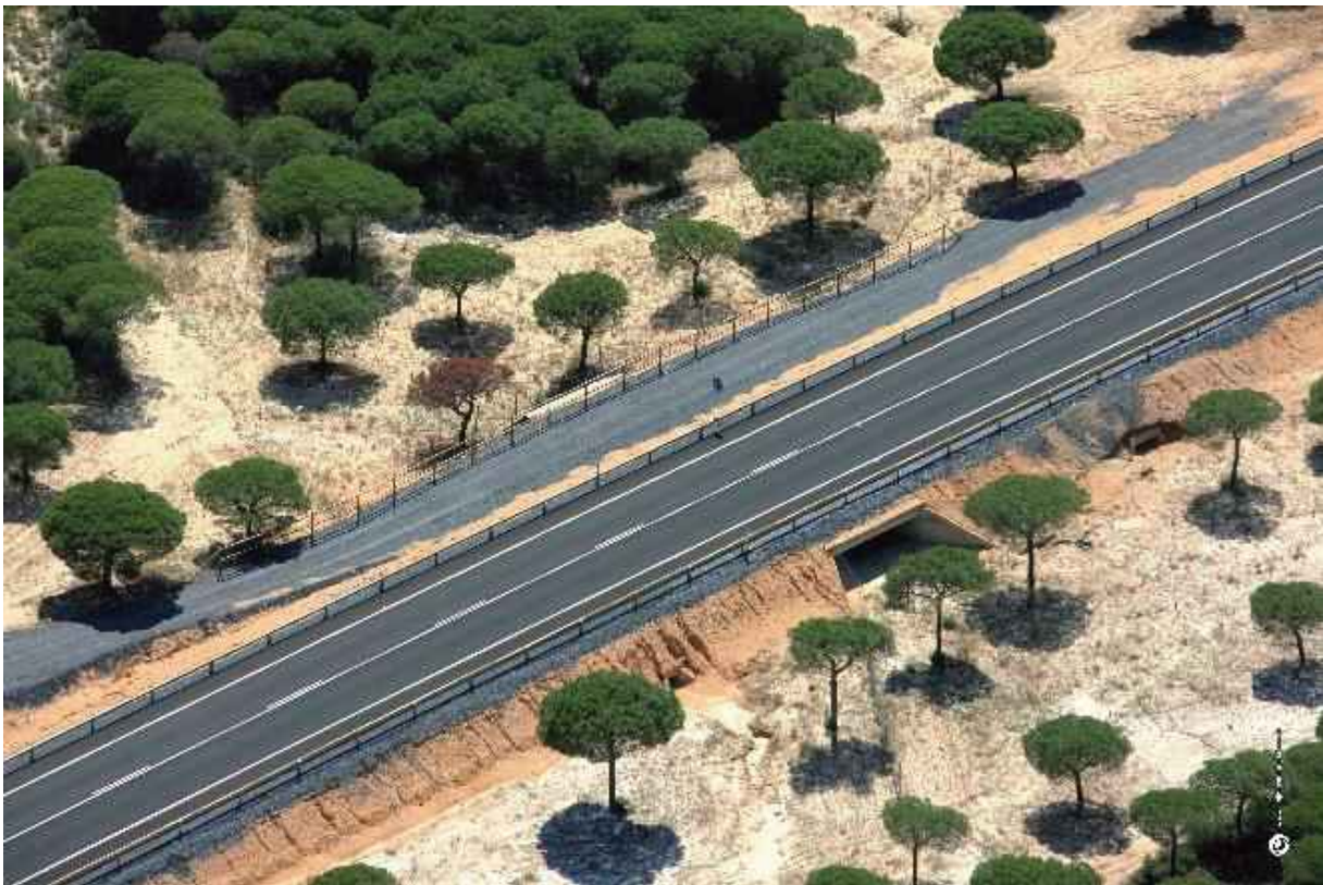
Vista aérea de paso inferior en la A-494, en el límite suroccidental del Espacio Natural de Doñana. Foto: Agencia de Obra Pública de la Junta de Andalucía.
