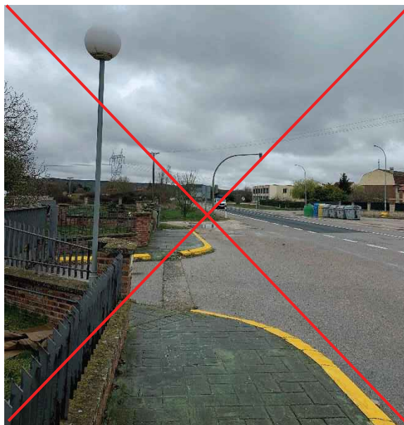
Figura 4.1.5. Ejemplo de iluminación de vía periurbana en el que se han utilizado luminarias tipo globo, que provocan la dispersión de la luz en todas direcciones, disminuyendo, además, su capacidad de iluminación sobre la vía. Foto: Junta de Castilla y León.
