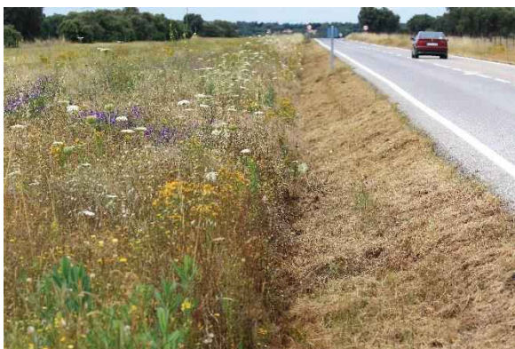
Figura 4.3.1. Cuneta desbrozada mecánicamente y limpia de residuos. Foto: Eloy Revilla.
