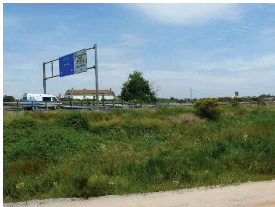
Figura 2.2. Margen con vegetación natural creciendo en el talud de la A-49 a la altura de Rociana del Condado (Huelva). La vegetación herbácea y subarborescente permite la presencia de insectos, aves o micromamíferos. Este tipo de parches de vegetación pueden tener valor de conservación en paisajes altamente humanizados donde la vegetación nativa sea limitante. Foto: Jacinto Román.
