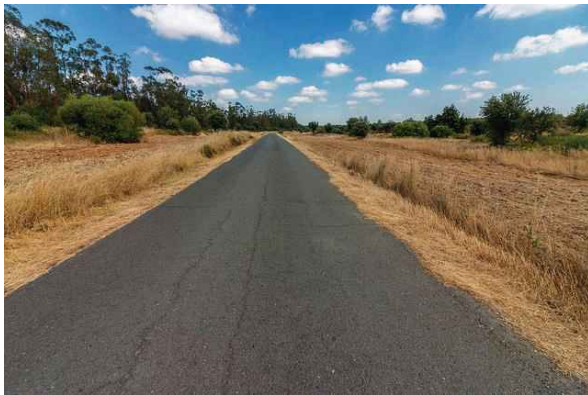
Figura 4.4.1. Tratamiento de márgenes mediante siega y arado para evitar el inicio de incendios forestales en el margen de la carretera. Foto: Jacinto Román.
