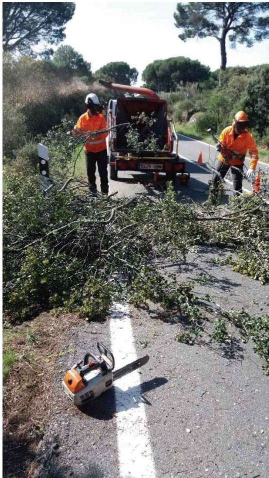
Figura 4.9.1. Desbroce manual de cuneta en zona forestal que limita la presencia de fauna en las inmediaciones de la calzada y aumenta su distancia de detección por parte de los conductores, disminuyendo así las probabilidades de colisión con vehículos. Foto: Comunidad de Madrid.
