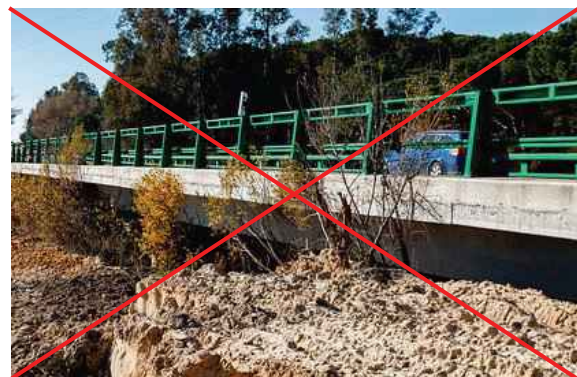
Figura 4.2.2. Obras de sustitución de un puente convencional por un viaducto para aumentar la permeabilidad de la infraestructura en las inmediaciones del Parque Nacional de Doñana. Desafortunadamente no se contempló la opción de usar pantallas fonoabsorbentes como medida coadyuvante. Foto: Jacinto Román.
