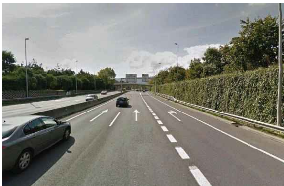
Figura 4.2.1. Autovía dotada con pantallas acústicas para reducir el ruido proveniente de la infraestructura. El ajardinamiento posterior mejora su estética, aunque no añade capacidad fonoabsorbente. Foto: Gobierno Vasco.
