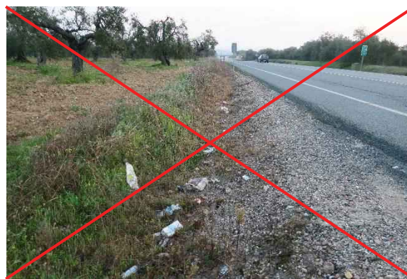
Figura 4.3.2. Cuneta desbrozada mediante la aplicación de herbicidas y con múltiples residuos. Foto: Eloy Revilla.
