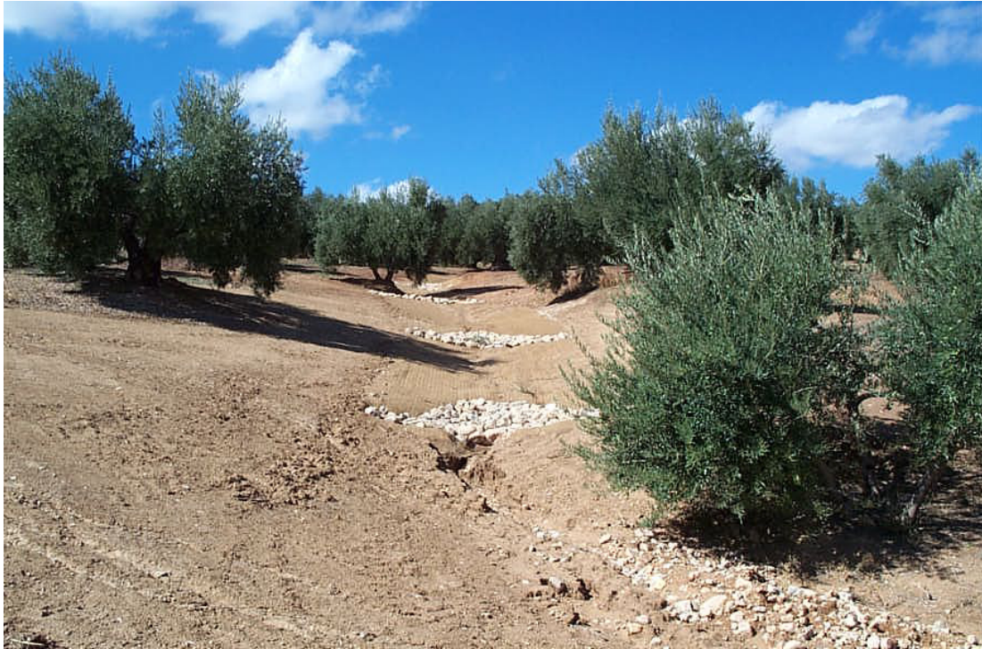
Reparación de una cárcava con mantas orgánicas en Campotéjar (Granada). (Fuente: V. Contreras)
