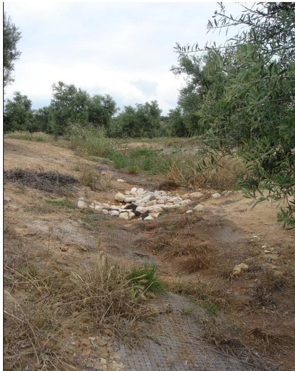
Reparación de una cárcava en olivar con mantas orgánicas.
