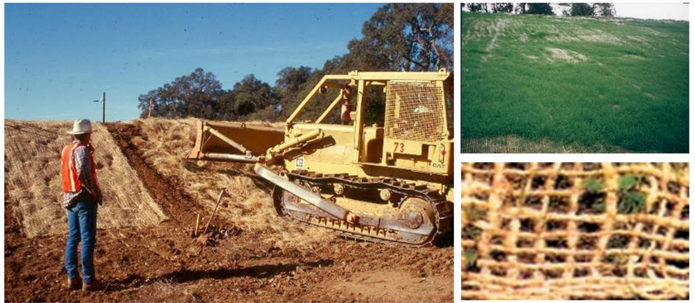
Malla orgánica de yute para la protección del suelo y control de la erosión.
