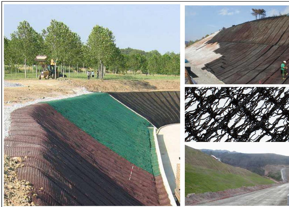
Malla volumétrica para el control de la erosión en taludes.
