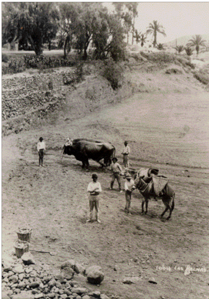
Figura 64. La rápida riqueza generada por el cultivo del plátano explica el traslado, mediante bestias, de grandes cantidades de suelos fértiles desde las zonas de medianía hacia la costa cálida. En la foto, trabajos de construcción de terrazas de cultivo, "sorribas", para la producción de plátanos
