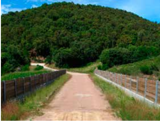
Figura 3.3. Paso superior con camino en el sector central de la estructura y dos franjas laterales revegetadas para la fauna. Foto: Departament de Territori i Sostenibilitat, Generalitat de Catalunya.
