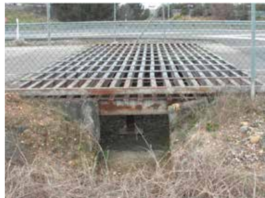
Figura 15.8 Paso canadiense con una apertura lateral que permite la salida de los pequeños animales que pudieran caer en su interior. Foto: Ministerio de Fomento.
