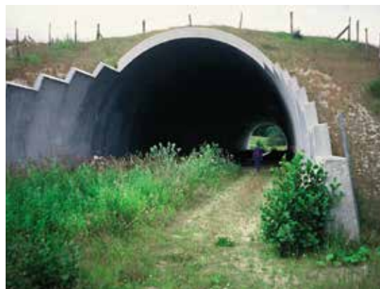
Figura 7.3. Restitución de un camino forestal compatible con el paso de fauna silvestre. Foto: M. Fernández Bou.
