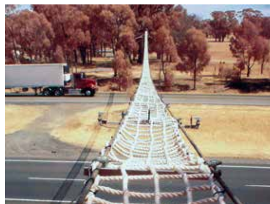
Figura 4.3. Paso de puente de malla. En zonas con alto riesgo de incendio forestal es indispensable el uso de materiales ignífugos para evitar la propagación de fuego. Foto: Kylie Soanes.
