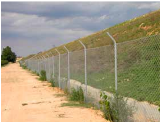
Figura 13.2. Instalación del cerramiento en la base de un terraplén. Foto: F. Navàs.
