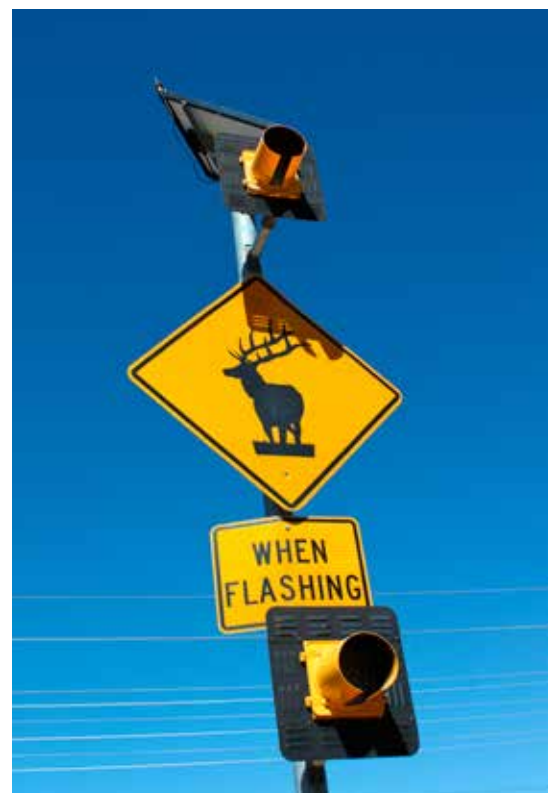
Figura 17.3. Señal de advertencia de peligro que emite destellos luminosos y que se activa mediante sensores de detección de fauna (ADS). Foto: C. Rosell.
