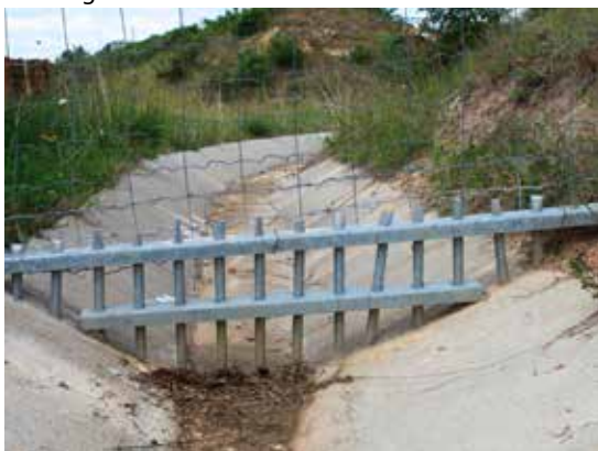
Figura 13.9. Dos alternativas de sistemas destinados a impedir el paso de animales por los puntos de intersección del cerramiento con las cunetas de drenaje perimetral. Fotos: Minuartia.
