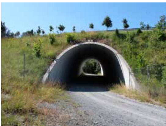
Figura 7.4. El camino sin pavimentar y el cerramiento bien adosado a las aletas favorecen el paso de fauna. Foto: M. Fernández Bou.
