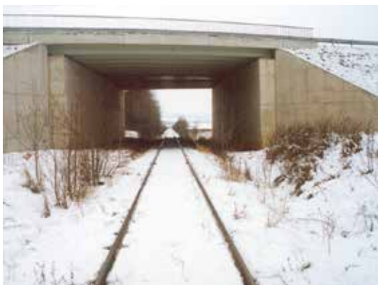
Figura 7.2. Paso de una vía de ferrocarril que combina el paso poco frecuente de trenes con el de fauna. Foto: V. Hlavac.
