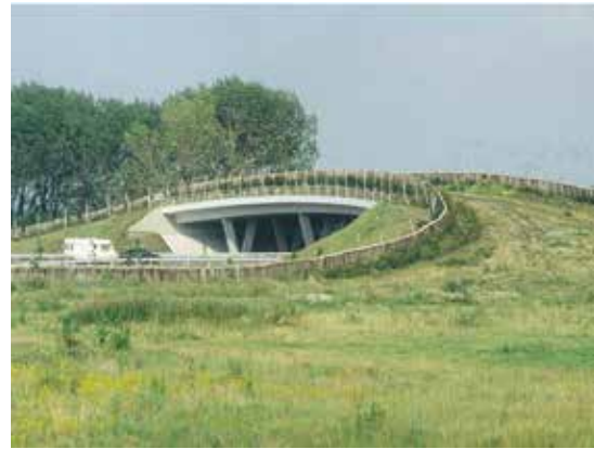
Figura 2.4. Paso situado en un terreno llano, con rampas de acceso con ligera pendiente. Foto: P. Farkas.
