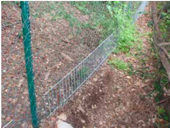
Figura 13.5. Refuerzo para jabalí en un tramo del vallado especialmente conflictivo. Foto: Túnel Barcelona-Cadix.
