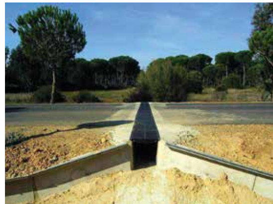
Figura 11.3. Paso de anfibios con estructura de guía formando embudo. Foto: GIASA.
