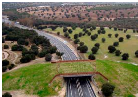
Dirección General de Carreteras, Comunidad de Madrid
