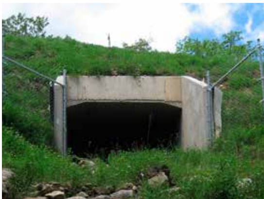
Figura 8.4. La correcta colocación del cerramiento facilita la localización de los accesos. Foto: M. Fernández Bou.
