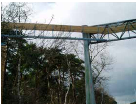
Figura 4.2. Plataformas de madera instaladas en un soporte de señalización de una autopista. Foto: H. Bekker.
