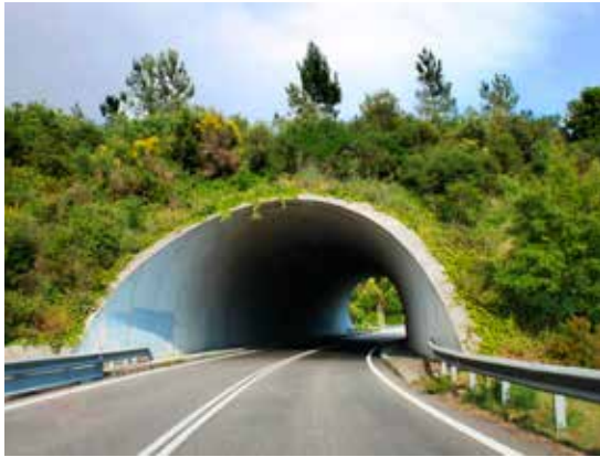
Figura 2.3. Paso situado en un tramo entre desmontes que permite depositar materiales excedentes de la excavación. Foto: M. Fernández-Bou.
