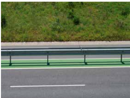
Figura 16.2. Mediana de separación de carriles sin vegetación que puede ser adecuada en tramos en los que la proliferación de topillos u otras presas atraen a rapaces o carnívoros acarreado un aumento del riesgo de atropellos. Foto: C. Rosell.
