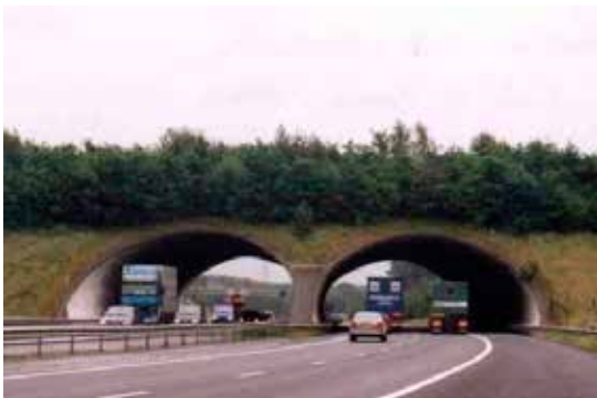
Figura 1.6. Pantalla vegetal para reducir las perturbaciones generadas por el tráfico. Foto: V. Hlavac.
