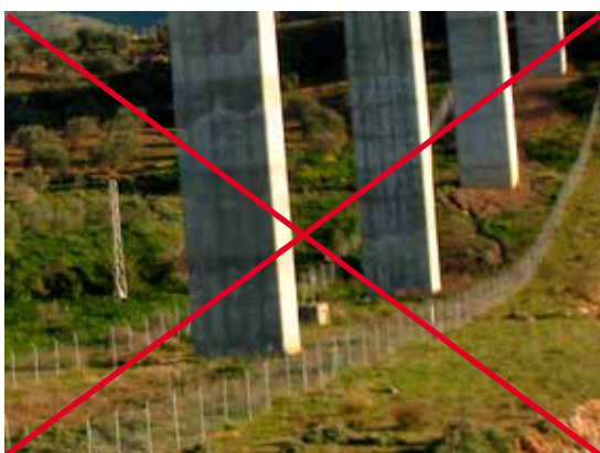
Figura 5.9. Sector bajo un viaducto con cerramiento perimetral en un extenso sector de su longitud, que impide el paso de los animales. Foto: Minuartia.
