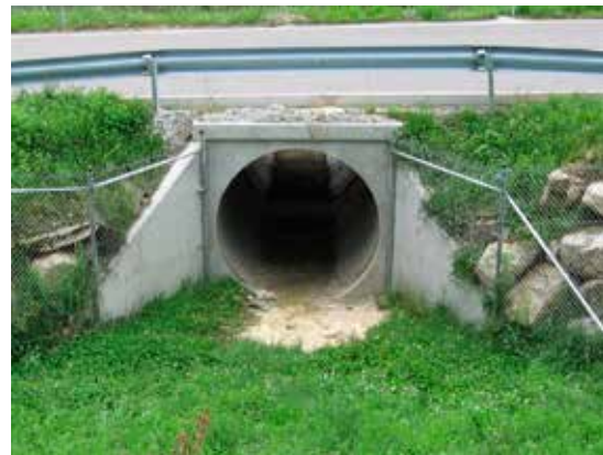
Figura 12.6. Correcta instalación del cerramiento perimetral. Foto: M. Fernández-Bou.
