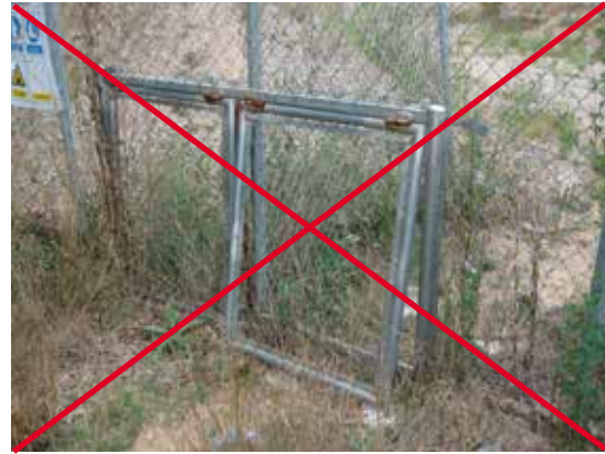
Figura 15.11. Puertas basculantes de escape para medianos carnívoros que quedan entreabiertas a causa de la oxidación de las bisagras y posibilitan la entrada de animales al interior del vallado. Fotos: F. Navàs.
