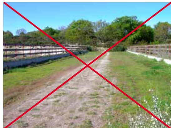
Figura 2.8. Circulación motorizada por un paso superior específico para la fauna y pantalla lateral que no es completamente opaca. Foto: C. Rosell.
