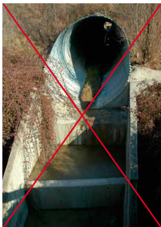
Figura 9.11. Bajante escalonado que constituye una trampa para la fauna. Foto: F. Navàs.
