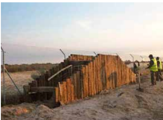
Figura 15.5. Rampa de escape. A la izquierda, vista desde el interior, durante el proceso de construcción, y a la derecha, desde el exterior, una vez finalizada. Véase en esta la eliminación de la malla en la parte superior de la rampa, para facilitar el salto animal. Foto: Agencia de Obra Pública. Junta de Andalucía.
