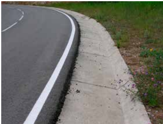
Figura 20.2. Cuneta que permite un fácil acceso a los márgenes de la vía de los animales que hayan cruzado la calzada. Foto: F. Navàs.
