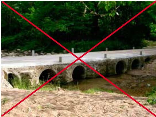
Figura 10.2. Drenajes situados en un badén que dificultan el paso de peces. Foto: F. Navàs.
