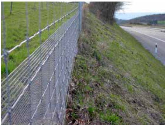
Figura 14.2. Instalación de un refuerzo en la parte exterior de la malla convencional. Foto: C. Rosell.
