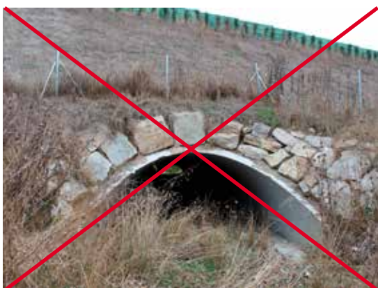
Figura 12.7. Instalación incorrecta del cerramiento perimetral, ya que no guía a los animales a las entradas del paso. Foto: M. Fernández-Bou.
