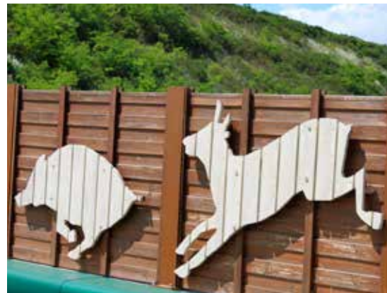
Figura 2.6. Las pantallas se utilizan en ocasiones como soporte para elementos ornamentales o de información a los usuarios de la vía sobre actuaciones relativas a biodiversidad. Foto: C. Rosell.
