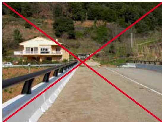
Figura 3.6. La franja lateral destinada a la fauna debería estar cubierta de tierras pero en este caso se han utilizado gravas. Además, la ubicación es poco adecuada debido a la proximidad de edificaciones. Foto: F. Navàs.
