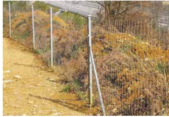
Dirección General de Carreteras, Comunidad de Madrid
