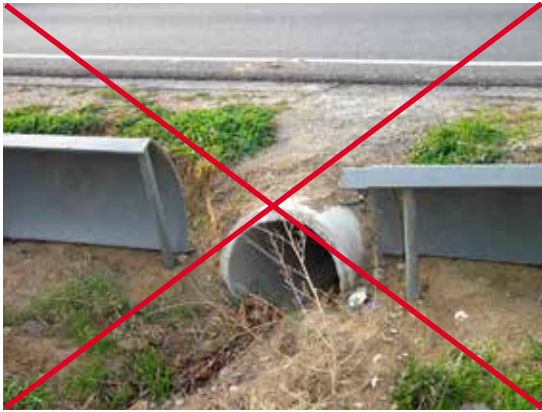
Figura 11.10. Desajuste entre la estructura de guía y el acceso al paso para anfibios. Foto: C. Rosell.
