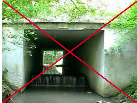
Figura 10.3. Escalón en el interior del drenaje que supone un obstáculo para el movimiento de fauna acuática. Foto: J. Dufek.
