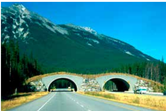
Figura 1.3. Bóvedas que permitieron la construcción del ecoducto en un vía en funcionamiento. Foto: H. Bekker.
