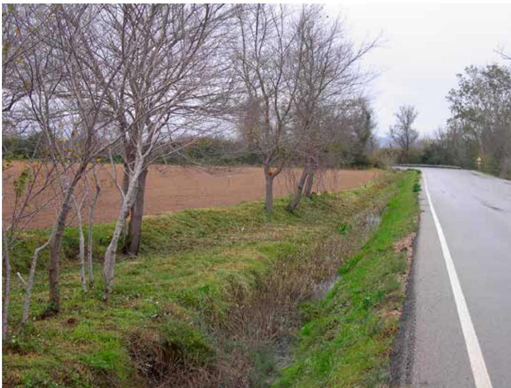
Figura 16.1. Desbroces para facilitar la visibilidad a los conductores y reducir los refugios para los animales en un tramo de carretera con alta concentración de accidentes causados por jabalíes y cérvidos. Foto: C. Rosell.
