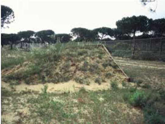
Figura 15.3. Sistema de escape consistente en tierras que forman una rampa, visto desde el interior de la vía. Foto: H. Bekker.
