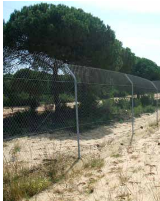
Figura 13.8. Cerramiento específico para lince ibérico. Foto: Agencia de Obra Pública. Junta de Andalucía.
