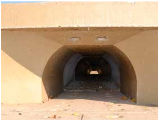
Figura 11.2. Vista del interior de un paso para anfibios de sección semicircular. Las paredes verticales y la base plana facilitan el avance de los anfibios. Foto: M. Puky.
