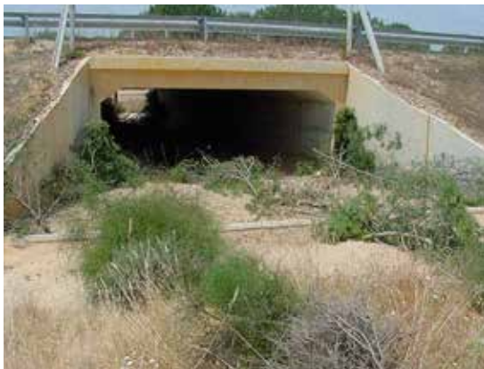
Figura 12.5. La disposición de hileras de ramas y las re-vegetaciones facilitan la conducción de la fauna hacia el interior de la estructura. Foto: P. Robles.
