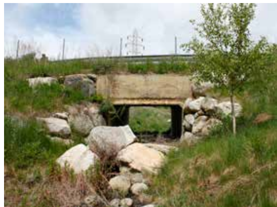
Figura 8.5. Integración del acceso en los taludes del terraplén. Foto: M. Fernández Bou.
