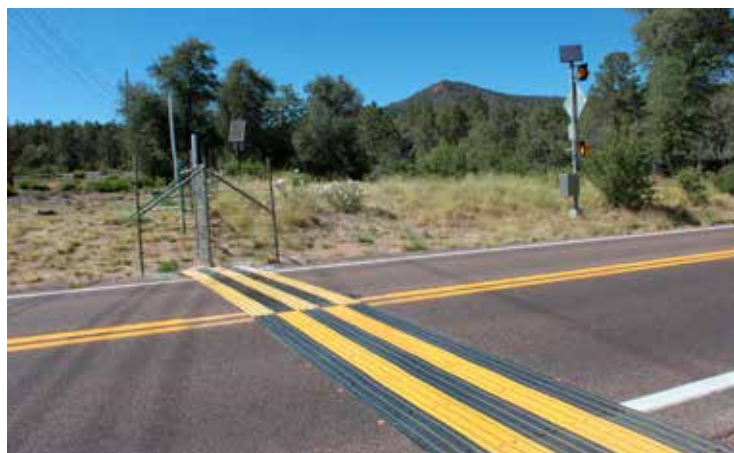
Figura 15.9. Placa electrificada para impedir la entrada de animales a través de una vía de acceso pavimentada. Foto: C. Rosell.
