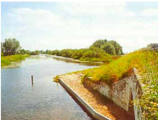
Figura 9.3. Rampa que facilita una óptima conexión de las plataformas secas del drenaje con los hábitats naturales de su entorno. Foto: H. Bekker.
