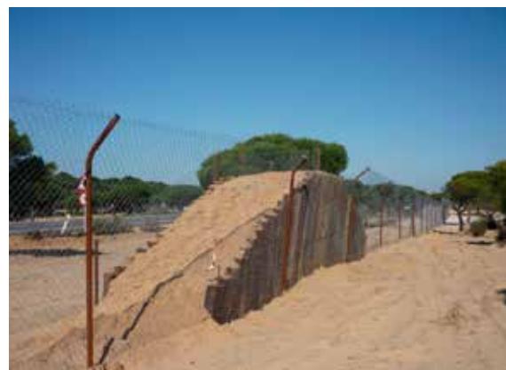
Figura 15.5. Rampa de escape. A la izquierda, vista desde el interior, durante el proceso de construcción, y a la derecha, desde el exterior, una vez finalizada. Véase en esta la eliminación de la malla en la parte superior de la rampa, para facilitar el salto animal. Foto: Agencia de Obra Pública. Junta de Andalucía.
