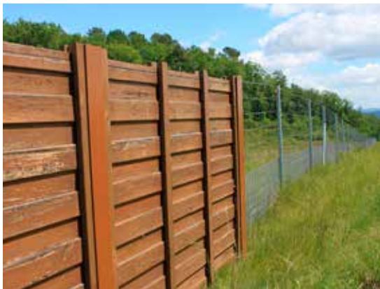
Figura 2.5. Las pantallas del paso deben mantener una perfecta continuidad con el cerramiento perimetral de la vía. Foto: C. Rosell.
