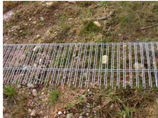
Figura 13.6. Detalle del refuerzo de malla electrosoldada. Foto: C. Rosell.
