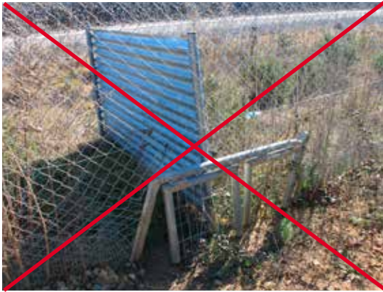
Figura 15.11. Puertas basculantes de escape para medianos carnívoros que quedan entreabiertas a causa de la oxidación de las bisagras y posibilitan la entrada de animales al interior del vallado. Fotos: F. Navàs.
