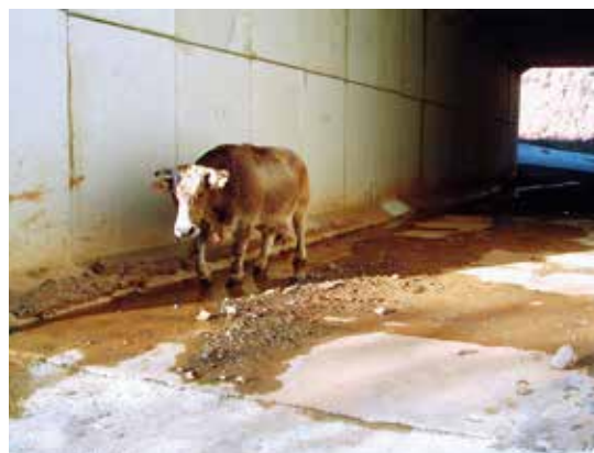
Figura 7.5. Los pasos destinados a ganado también pueden ser adaptados para facilitar su uso por fauna silvestre. Foto: E. Perapoch.
