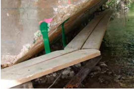
Figura 9.5. Plataforma para facilitar el desplazamiento de animales por el interior de un drenaje. Foto: Consejería de Fomento y Medio Ambiente, Junta de Castilla y León.
