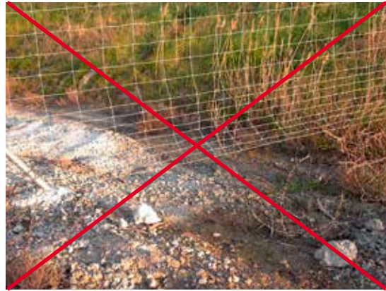
Figura 13.11. Malla sin enterrar que ha sido levantada por los animales. Foto: F. Navàs.
