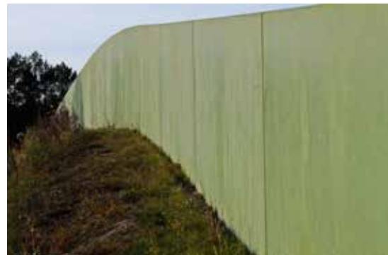
Figura 1.7. Las pantallas de madera tratada o placas de hormigón pintado requieren menor mantenimiento que la vegetación. Foto: C. Rosell.
