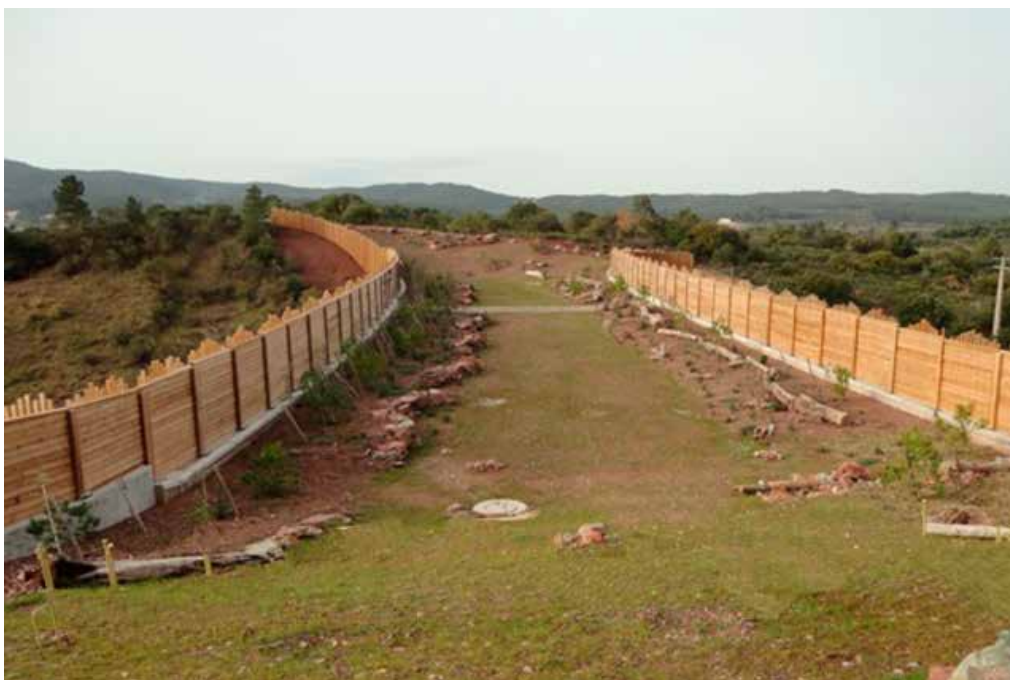
Figura 2.2. Paso superior con diversas medidas de acondicionamiento de refugios que favorecen su uso por parte de pequeños animales. Foto: Foto: S. Vanpee - Irstea.
