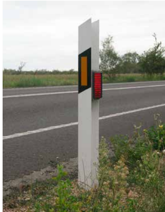
Figura 18.2. Existen diversos modelos de reflectores utilizados para proyectar las luces de los faros hacia el entorno de la vía. Estos sistemas requieren tareas frecuentes de mantenimiento y su efectividad es temporal. Fotos: C. Rosell.
