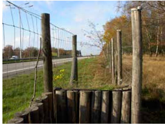
Figura 15.2. Otra visión de una de las rampas en la que se aprecia su disposición respecto a la malla de cerramiento. Foto: C. Rosell.
