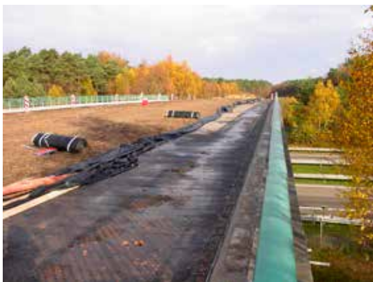
Figura 2.7. Aislamiento de la base de la estructura y drenaje de su superficie. Foto: C. Rosell.
