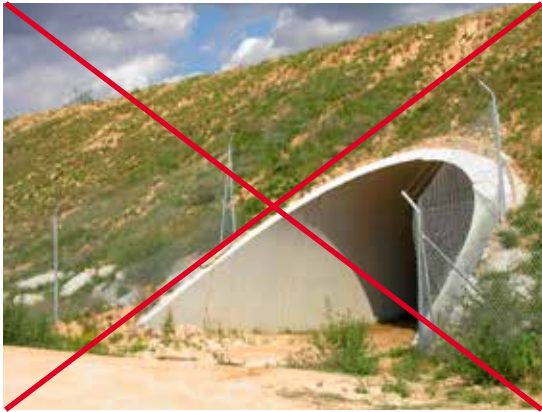
Figura 13.10. La malla debe conducir al paso sin dejar zonas abiertas de acceso al talud. Foto: C. Rosell.
