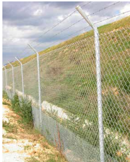
Figura 14.3. Cerramientos que combinan prolongación para impedir el salto de cérvidos y refuerzo basal para pequeños vertebrados. Foto: M. Fernández Bou.
