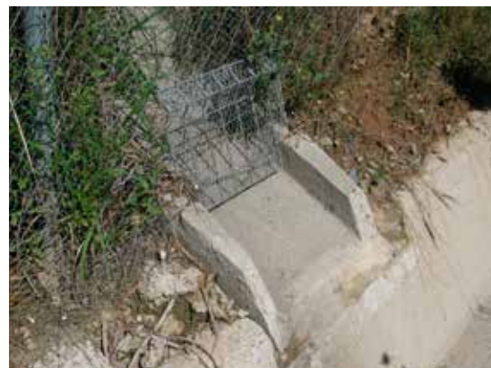
Figura 13.9. Dos alternativas de sistemas destinados a impedir el paso de animales por los puntos de intersección del cerramiento con las cunetas de drenaje perimetral. Fotos: Minuartia.
