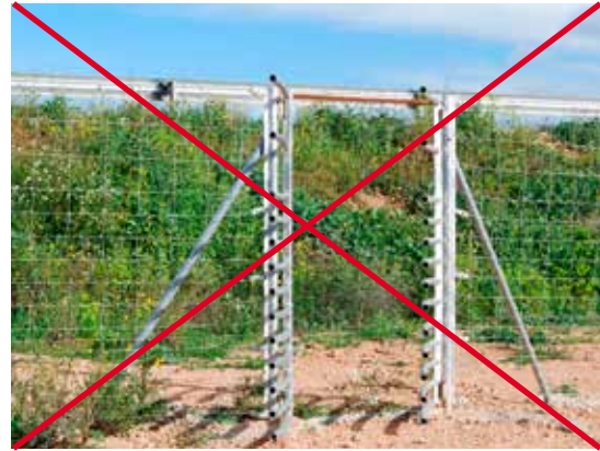
Figura 15.10. El diseño de este portillo de escape para ungulados posibilita que se mantenga completamente abierto permitiendo el libre acceso de animales (y personas) al interior del vallado. Fotos: F. Navàs.
