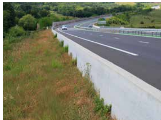
Figura 11.5. Cerramiento opaco de hormigón que constituye una óptima estructura de guía. Foto: C. Rosell.
