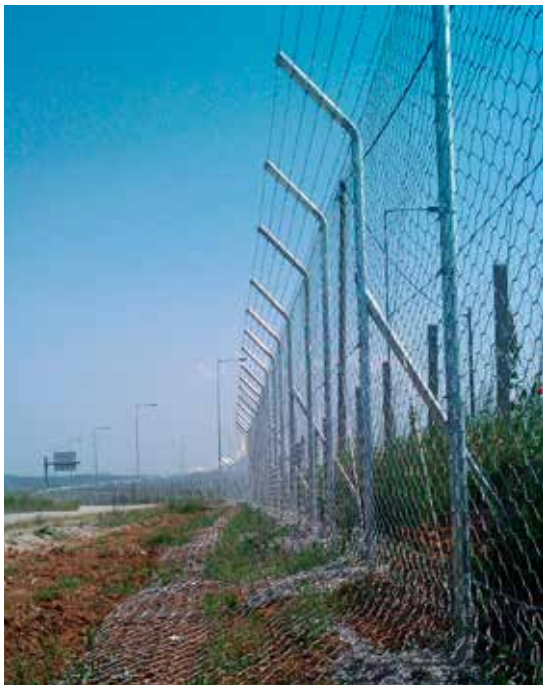
Figura 13.7. Vallado específico para oso, con visera superior y faldón inferior (antes de ser enterrado). Foto: L. Georgiadis.
