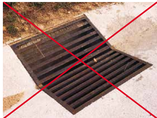
Figura 20.5. Las rejas protectoras de pozos o arquetas deben ser densas para evitar la caída de pequeños animales en su interior. Además es preferible que las paredes de estos se adapten para facilitar la salida de animales. Foto: C. Rosell.
