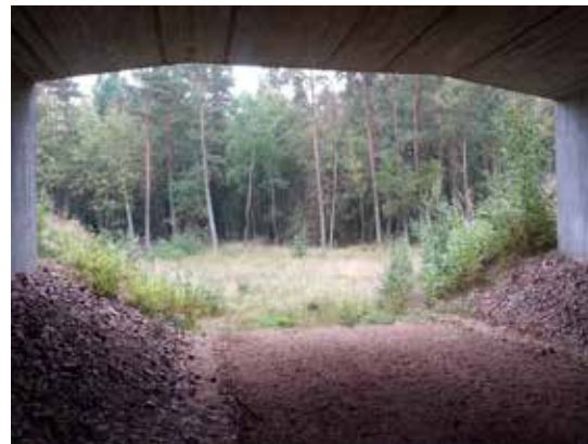
Figura 6.3. Paso inferior con la base de sustrato natural. La ausencia de luz y humedad impide el crecimiento de vegetación en el interior de la estructura. Foto: C. Rosell.
