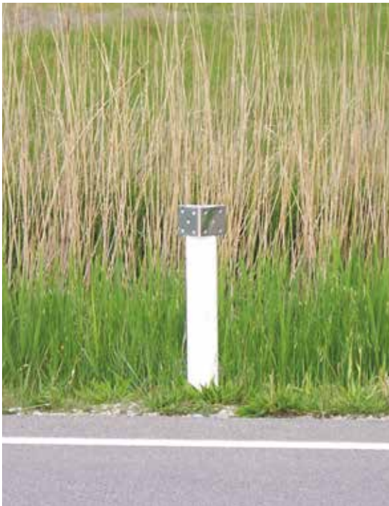
Figura 18.2. Existen diversos modelos de reflectores utilizados para proyectar las luces de los faros hacia el entorno de la vía. Estos sistemas requieren tareas frecuentes de mantenimiento y su efectividad es temporal. Fotos: C. Rosell.
