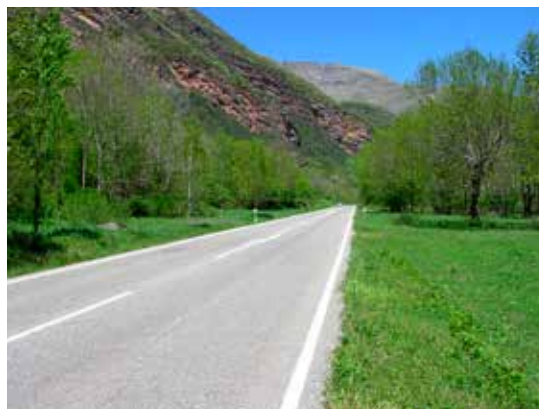
Figura 16.3. Márgenes desbrozados para reducir los refugios para animales en la zona adyacente a la calzada. Foto: F. Navàs.
