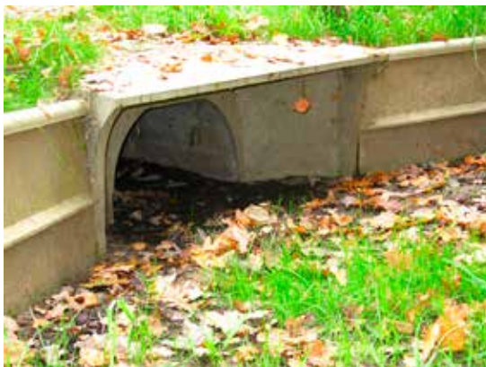
Figura 11.4. Paso de anfibios y estructura de guía constituidos por elementos prefabricados. Foto: M. Puky.
