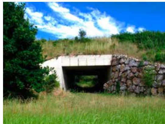
Figura 6.5. Estructura con un buen acondicionamiento de sus accesos. Foto: M. Fernández Bou.
