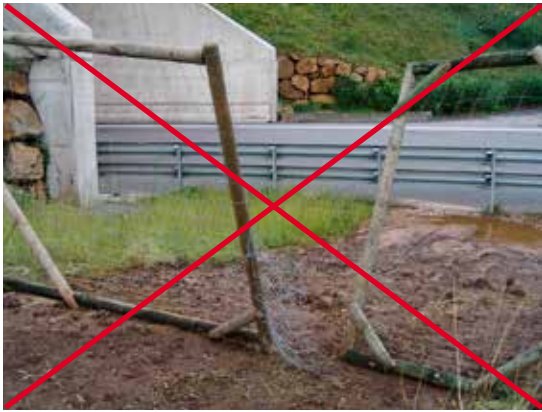
Figura 13.12. La falta de mantenimiento facilita la entrada de animales en las vías. Foto: F. Navàs.
