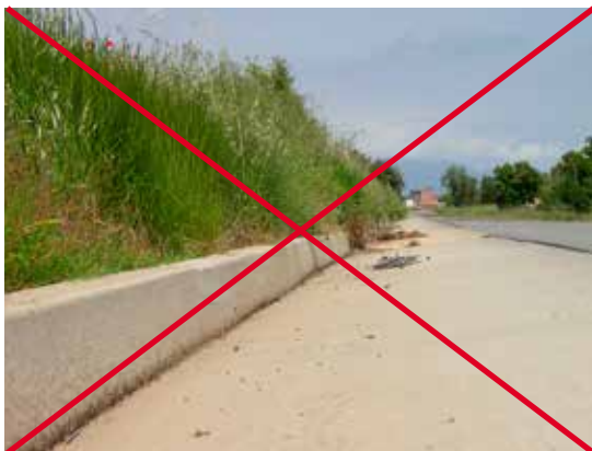
Figura 20.4. La pared vertical de la cuneta supone una barrera para los animales pequeños que caen en el interior de la calzada y no pueden salir de ella. Foto: C. Rosell.
