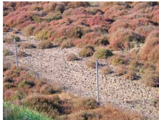
Figura 13.3. El cerramiento conduce los movimientos de los animales hasta localizar los pasos. Foto: C. Rosell.
