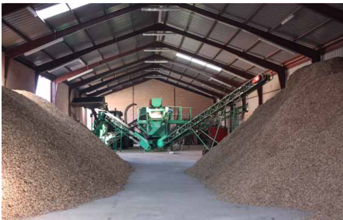
Fotografía 1: Interior del centro, maquinaria y producto.
