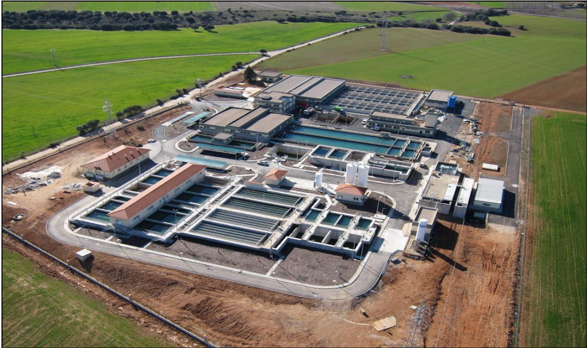
Ilustración 1: Estación de Tratamiento de Agua Potable (ETAP).
