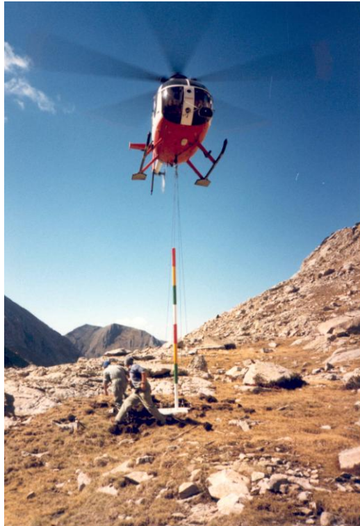
1985. Instalación de las primeras pértigas de control nival en el Pirineo
