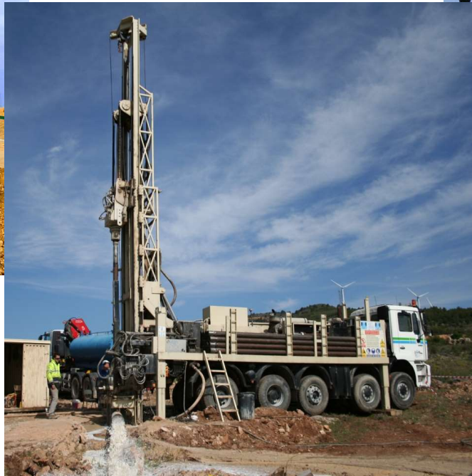
Sondeo de 1200 m para inyección en acuífero
