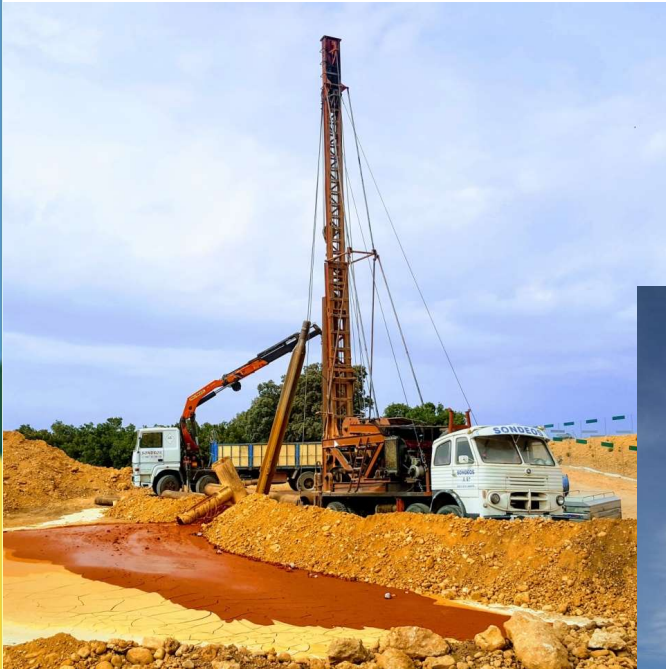
Sondeo de 998 m para extracción de salmuera por disolución
