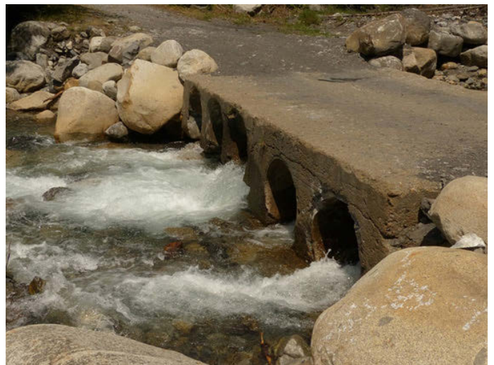
Foto 6. Río Vallibierna en Tramo 2, en el paso entubado. Valorar la localización de aforo
