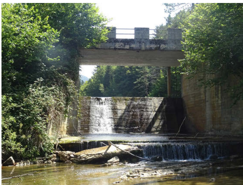
Foto 8: Presa de Koicha, sobre el río Urchuria, en la zona 2 de la reserva
