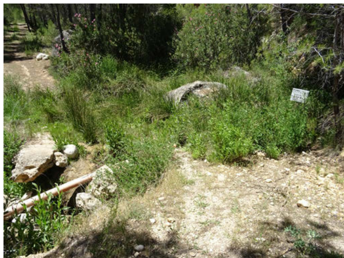
Foto 8. Cruce de camino que supone un obstáculo en la zona media de la RNF con la tubería de la captación de agua para uso humano en Llano de la Torre (Zona 2).
