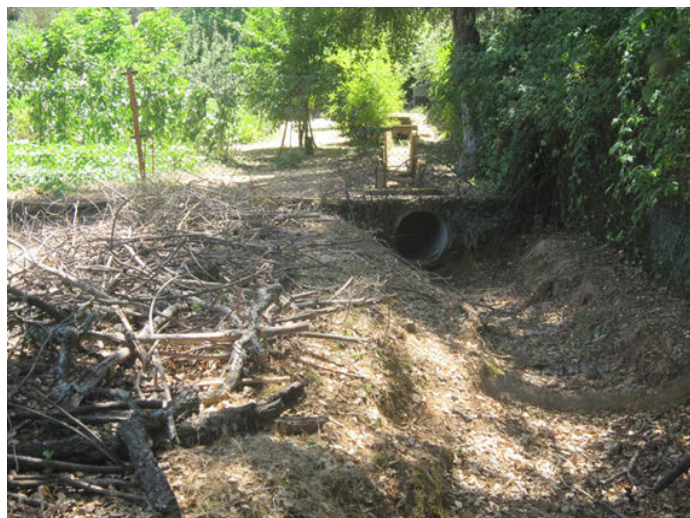
Foto 12.-El cauce se interna en una parcela, transformándose en una zanja de drenaje con sucesivos entubamientos
