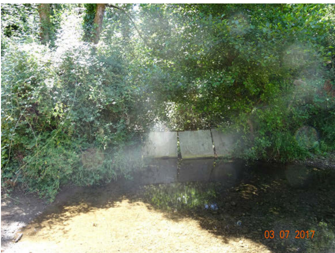
Foto 5.-Estructuras metálicas cortando el DPH
