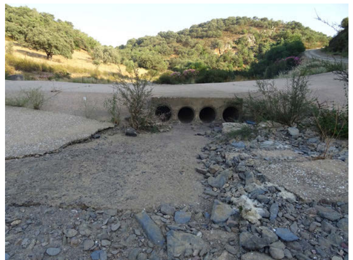
Foto 6: El mismo vado desde aguas arriba (franqueable en descenso, según caudal).
