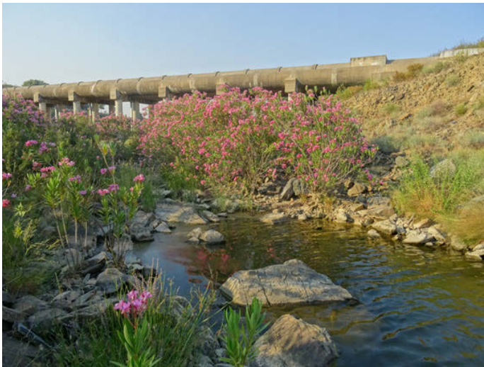
Foto 3: Puente de la conducción de agua zona final del tramo alto de la RNF.
