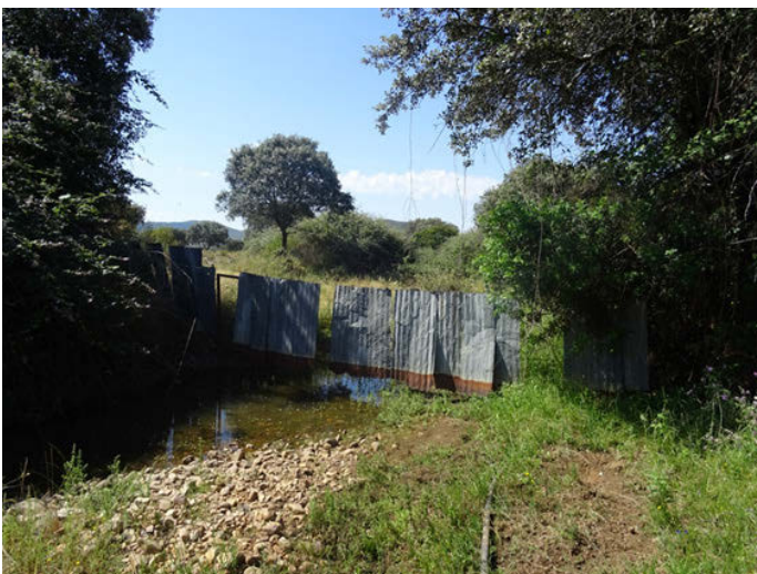
Foto 5: Cerramiento situado unos 50 m aguas arriba de la foto anterior, para evitar el paso del ganado a una pequeña huerta y captación no inventariada (manguera, en primer plano)
