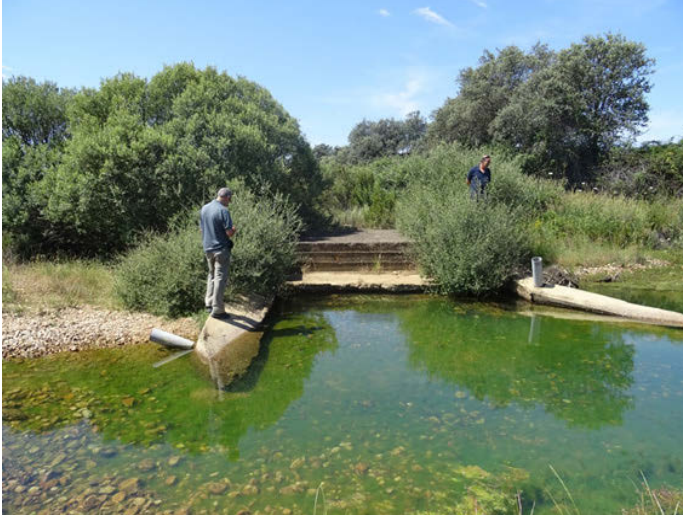
Foto 7: Vado obsoleto aguas arriba de la confluencia con el Aº de Fuente Escudero.
