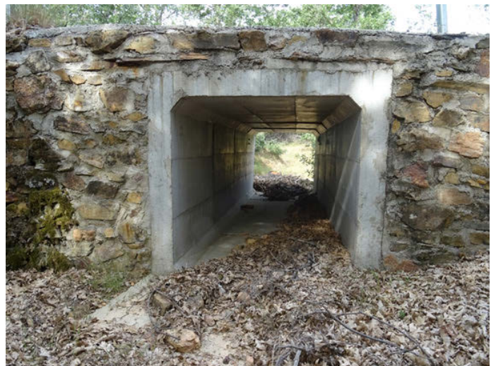
Foto 6: Puente con lecho cementado sobre río Mesto en zona 3.
