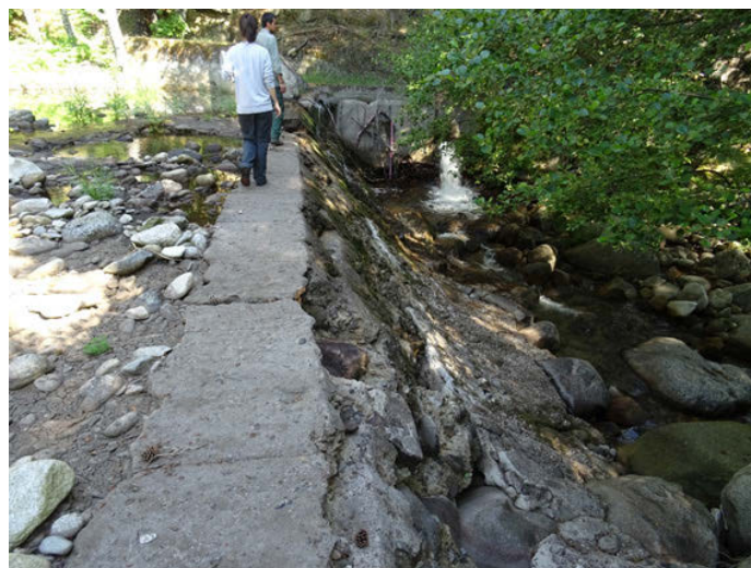
Foto 6: Primer azud en desuso y colmatado de los seis que contiene la reserva
