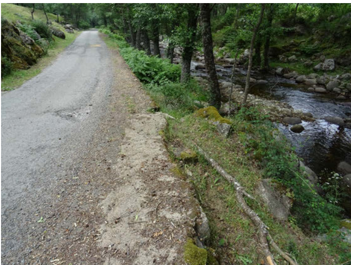
Foto 17: Pista paralela al cauce de la garganta
