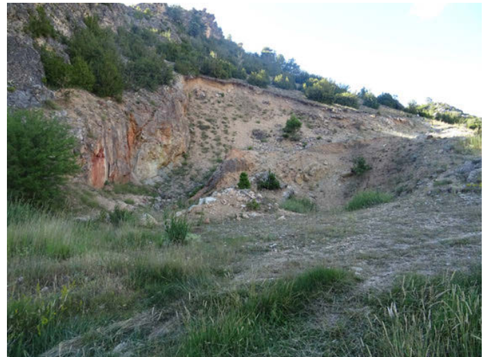
Foto 10: Antigua zona de extracción de áridos
