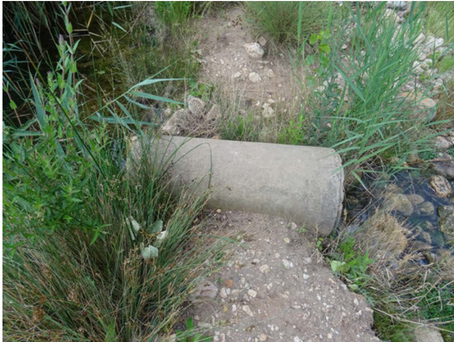
Foto 7: Pequeño obstáculo para para almacenar agua y crear un vado de paso.
