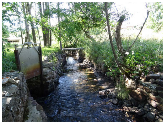
Foto 10: Canal de derivación del azud ES020RNF047_OBS_03 en el río Pisuerga.
