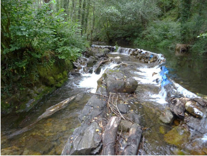
Foto 7: Obstáculo transversal con extracción de caudal en el río Tejeira (Zona 2).
