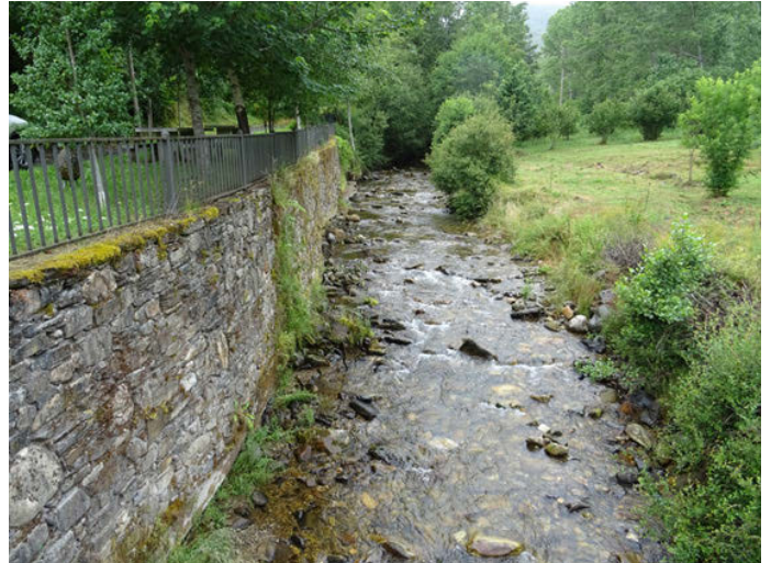
Foto 10. Estructura longitudinal y alteración de la vegetación riparia en la margen izquierda del río Tejeira, en el entorno de Villar de Acero (Zona2).
